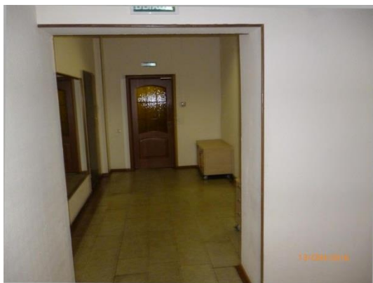
Фото № 21 Состояние внутренней отделки помещения
