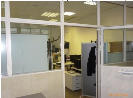
Фото № 17 Состояние внутренней отделки помещения
