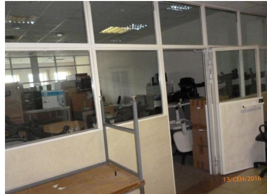
Фото № 16 Состояние внутренней отделки помещения
