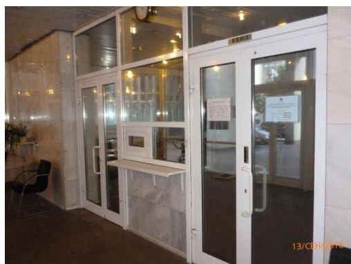
Фото № 2 Общий вход
