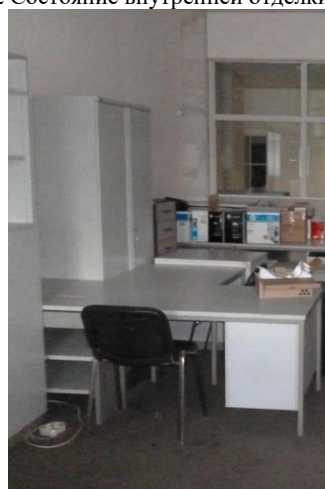
Фото № 14 Состояние внутренней отделки помещения
