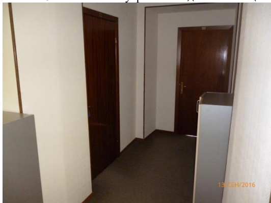
Фото № 25 Состояние внутренней отделки помещения
