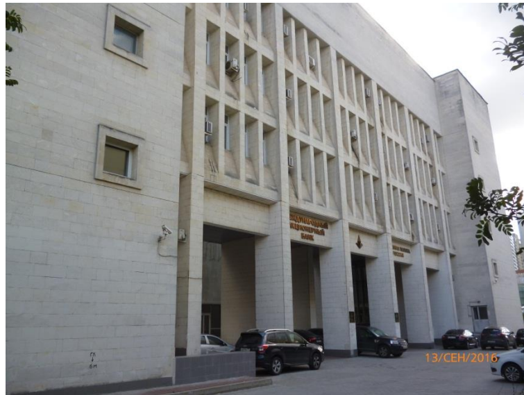
Фото 1. Внешний вид здания
