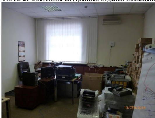
Фото № 23 Состояние внутренней отделки помещения
