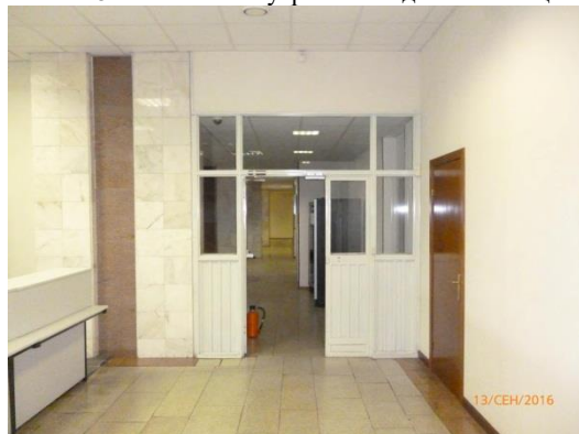
Фото № 10 Состояние внутренней отделки помещения
