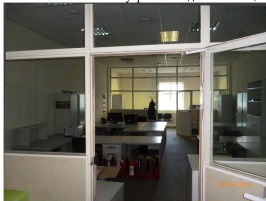
Фото № 12 Состояние внутренней отделки помещения
