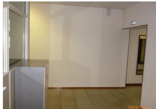
Фото № 20 Состояние внутренней отделки помещения
