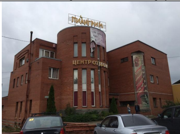
Общий вид здания
