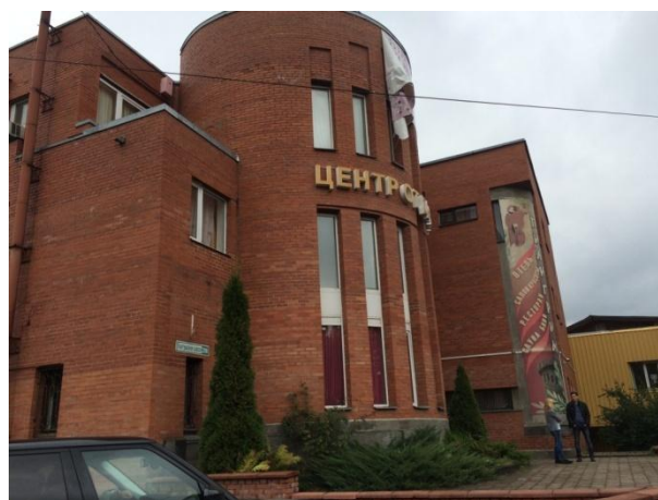
Общий вид здания
