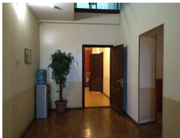
Внутренняя отделка помещений
