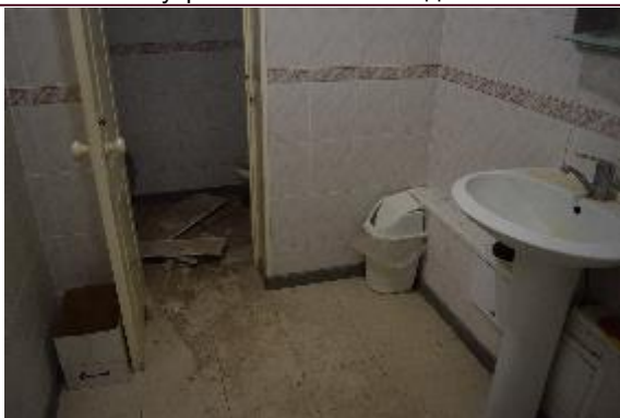
Внутреннее состояние здания
