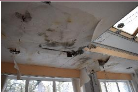
Внутреннее состояние здания
