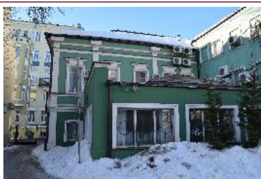
Внешний вид здания
