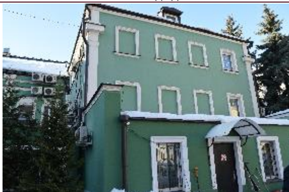
Внешний вид здания
