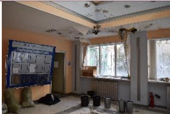
Внутреннее состояние здания
