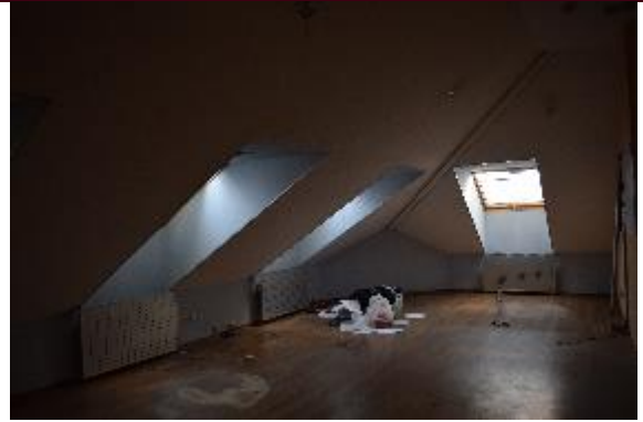
Внутреннее состояние здания
