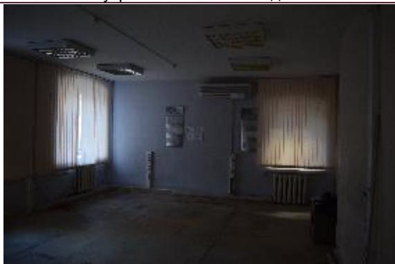
Внутреннее состояние здания
