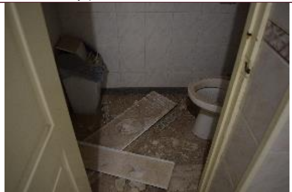
Внутреннее состояние здания
