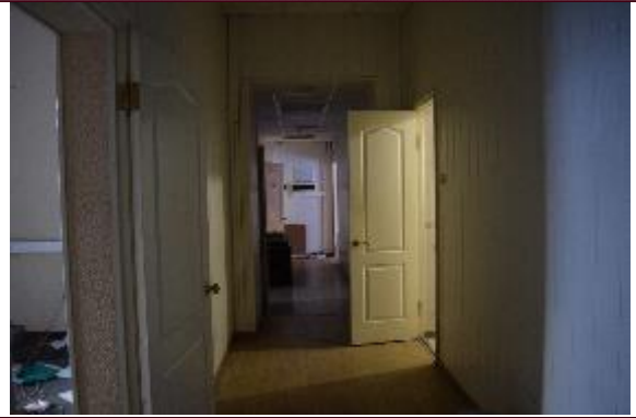
Внутреннее состояние здания
