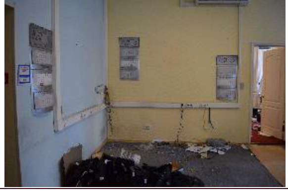
Внутреннее состояние здания
