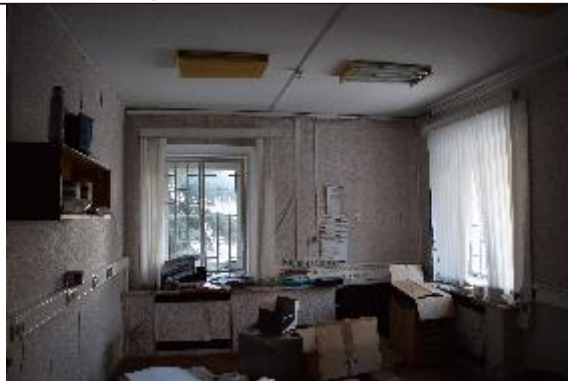
Внутреннее состояние здания
