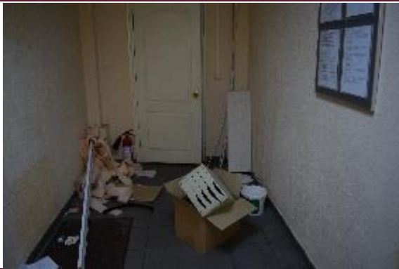
Внутреннее состояние здания
