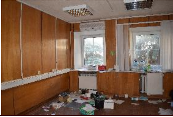
Внутреннее состояние здания
