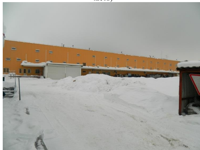
Офисно-складское здание (складская часть)
