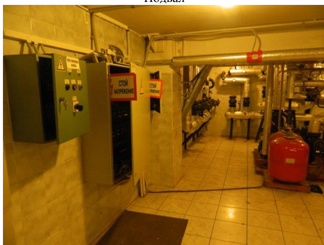
Насосное помещение Подвал
