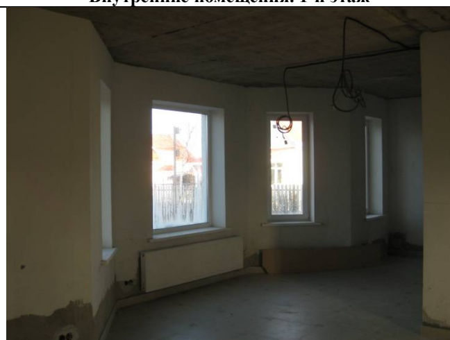
Внутренние помещения. 1-й этаж
