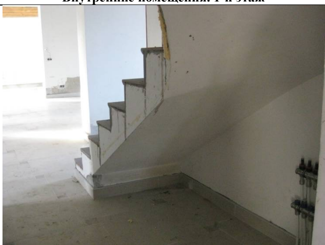
Внутренние помещения. 1-й этаж
