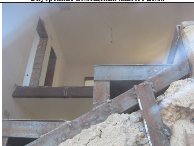
Внутренние помещения жилого дома
