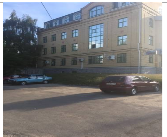
Фото № 2 Внешний вид здания
