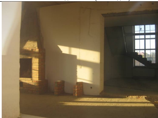
Внутренние помещения жилого дома
