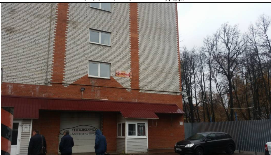
Фото № 2. Внешний вид здания
