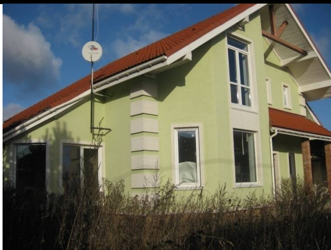
Внешний вид объекта
