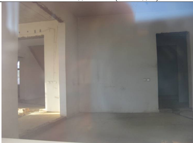
Внутренние помещения жилого дома
