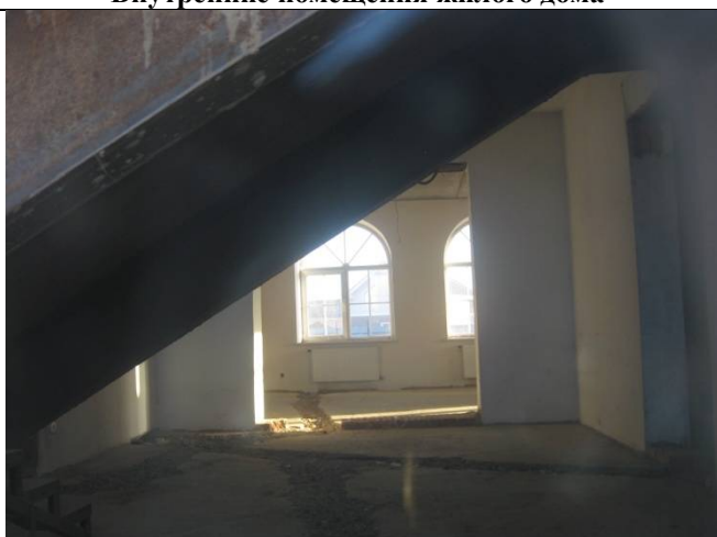
Внутренние помещения жилого дома
