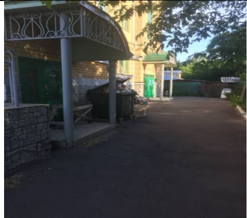
Фото № 4 Внешний вид здания
