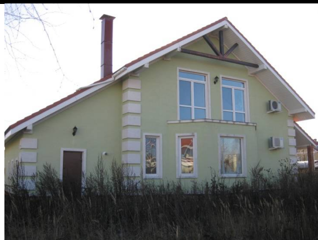
Внешний вид объекта
