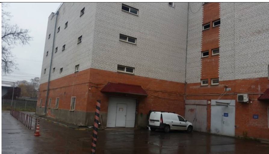
Фото № 1. Внешний вид здания
