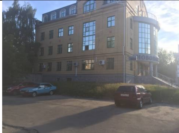
Фото № 3 Внешний вид здания
