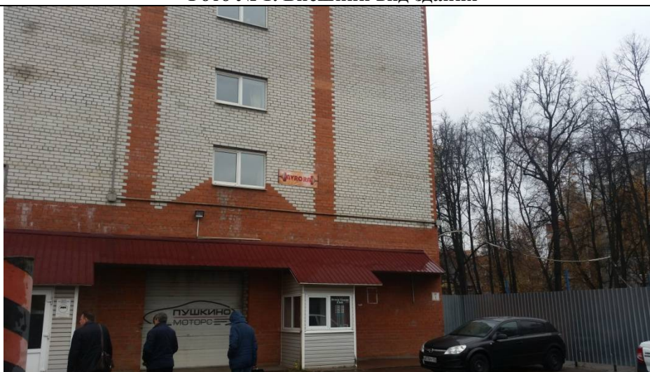
Фото № 2. Внешний вид здания
