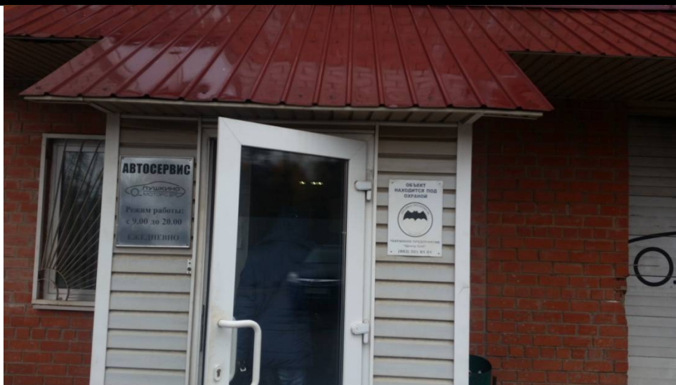
Фото № 3. Вход в здание
