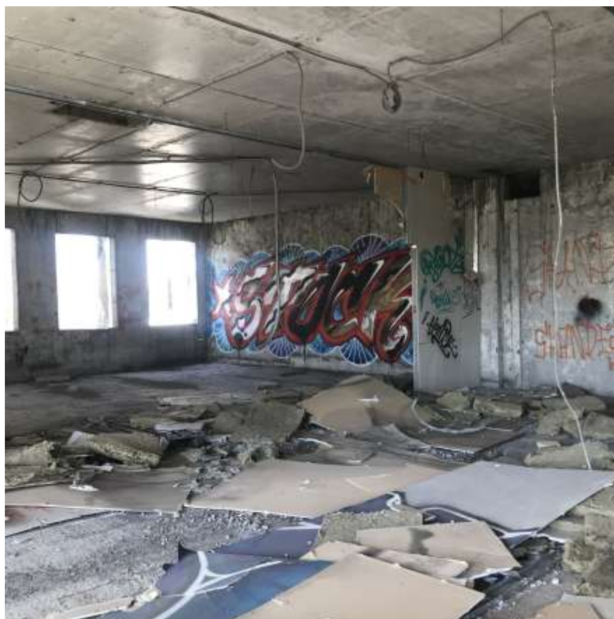
Фото внутренней части здания
