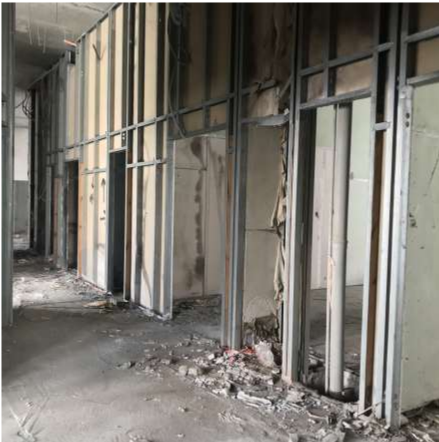
Фото внутренней части здания
