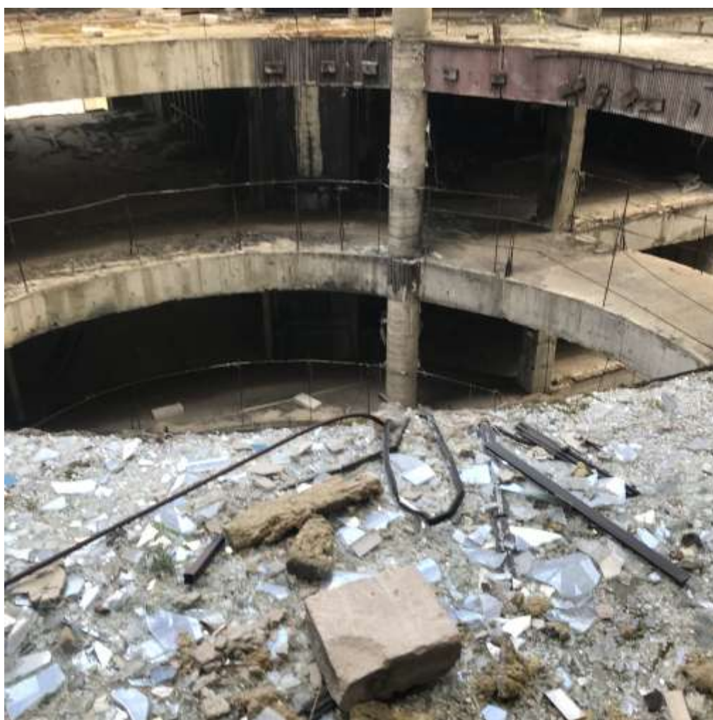
Фото внутренней части здания
