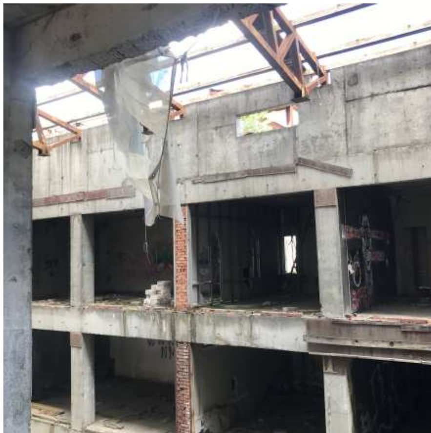
Фото внутренней части здания
