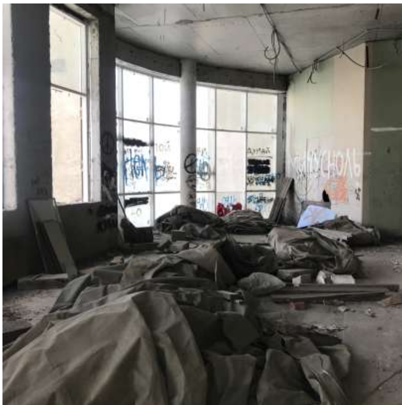
Фото внутренней части здания
