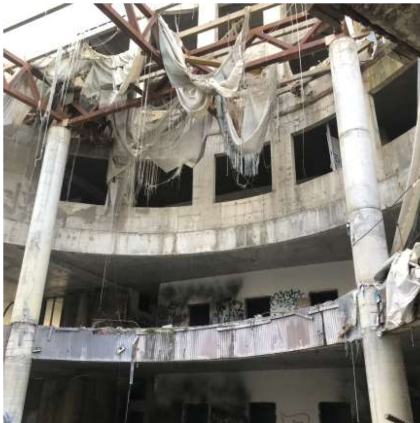
Фото внутренней части здания
