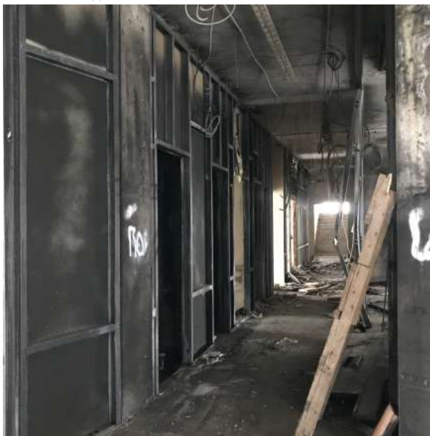
Фото внутренней части здания
