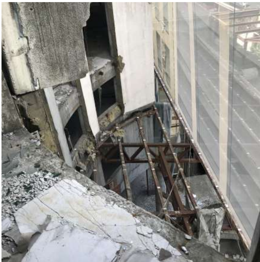
Фотографии технического состояния и физического износа объекта оценки.
