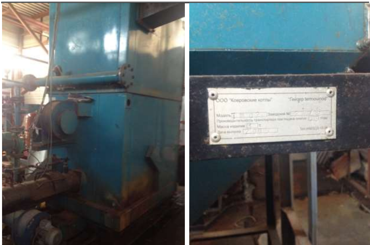
Фотография 63 - 64. Котел газовый напольный чугунный
