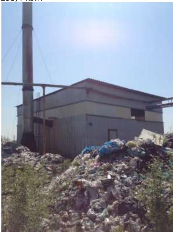
Фотография 29 - 30. Котельная, назначение: нежилое, общей площадью 101,7 кв.м
