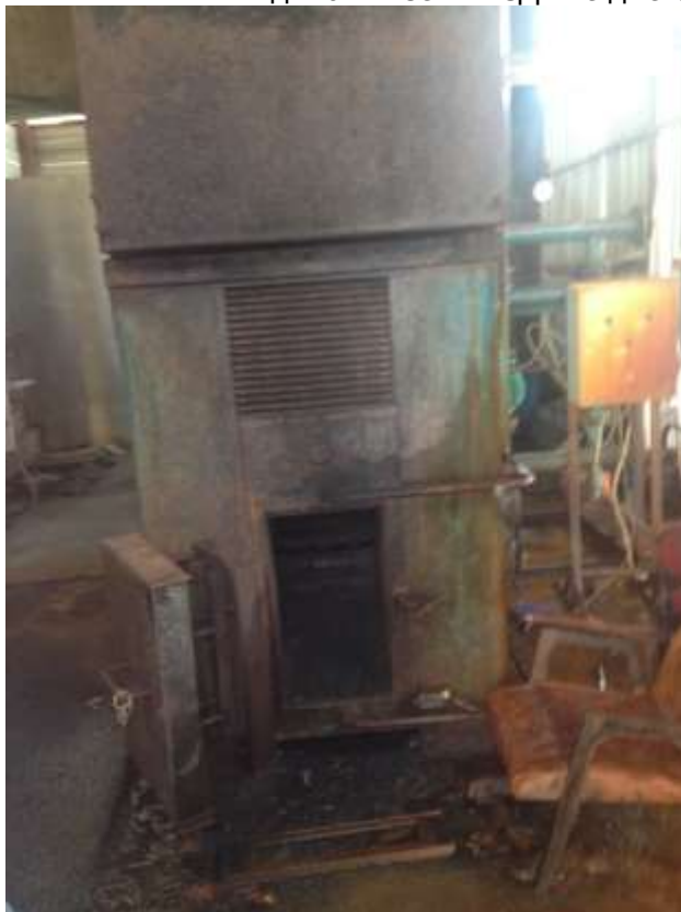
Фотография 61 - 62. Котел газовый напольный чугунный
