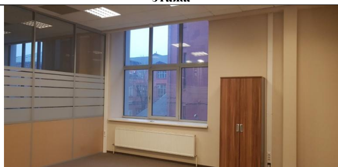
Фото 6. Состояние внутренних помещений 2-го этажа
