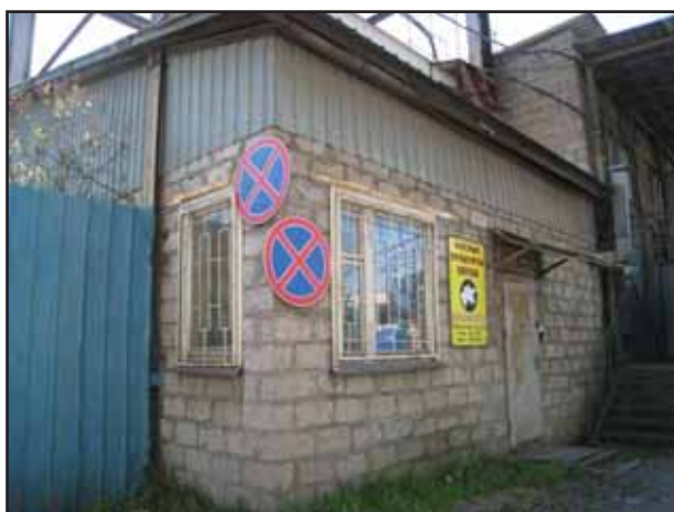
Фото № 11. Внешний вид здания склада
