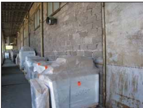
Фото № 23. Внешний вид здания склада
