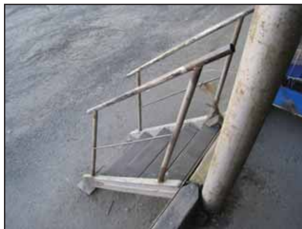
Фото № 16. Внешний вид здания склада
