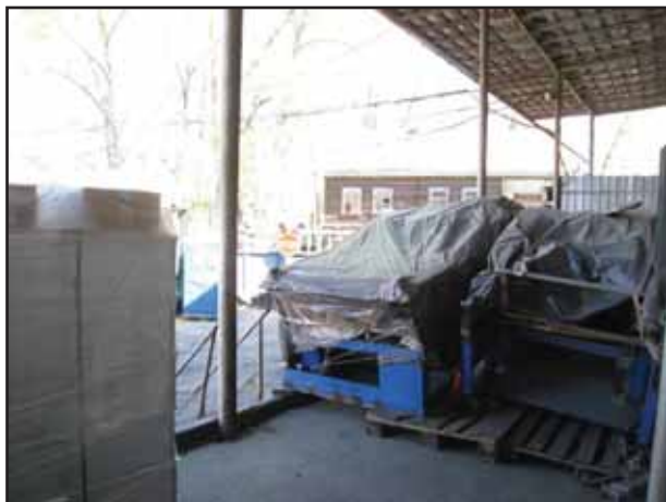
Фото № 13. Внешний вид здания склада
