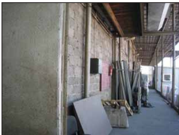
Фото № 15. Внешний вид здания склада
