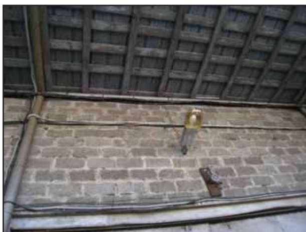
Фото № 17. Внешний вид здания склада
