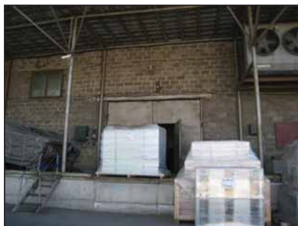
Фото № 18. Внешний вид здания склада
