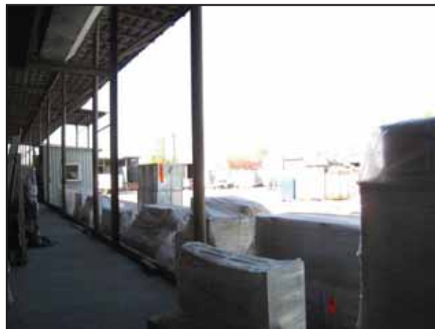
Фото № 14. Внешний вид здания склада
