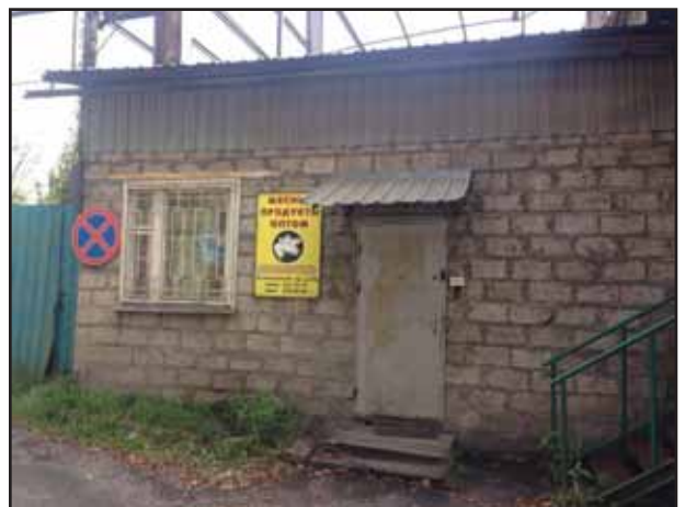
Фото № 24. Внешний вид здания склада
