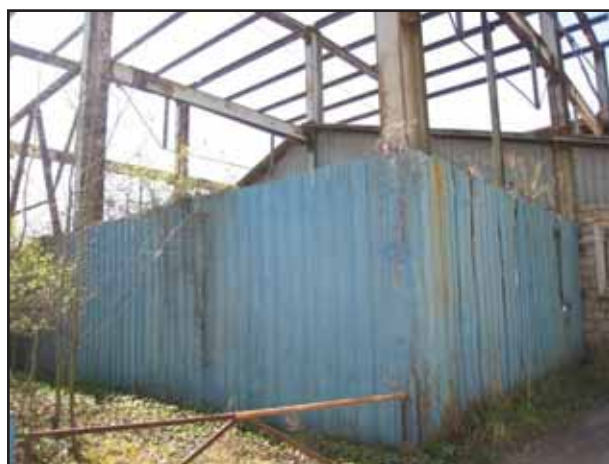
Фото № 12. Внешний вид здания склада
