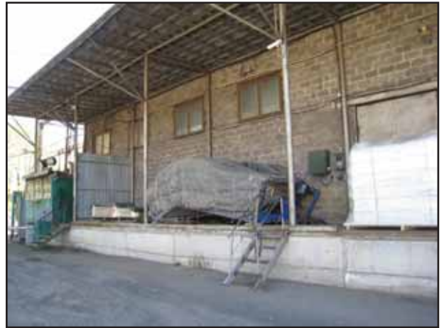
Фото № 20. Внешний вид здания склада
