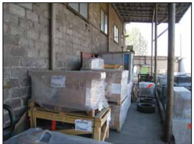
Фото № 22. Внешний вид здания склада
