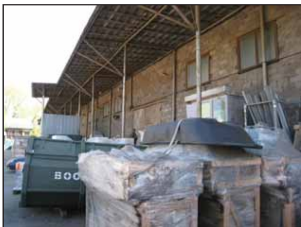
Фото № 9. Внешний вид здания склада
