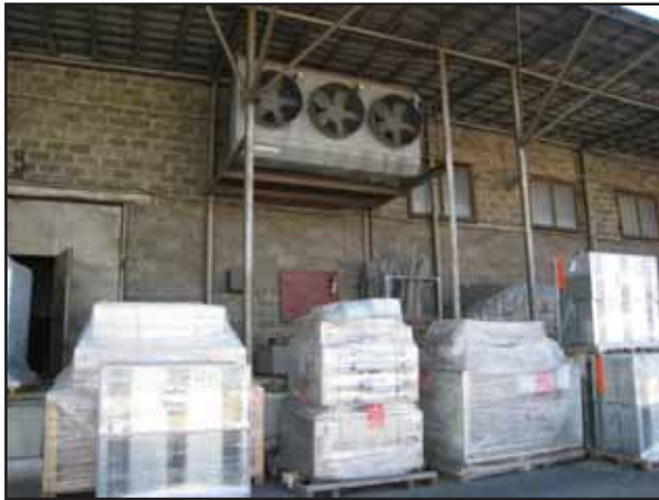
Фото № 19. Внешний вид здания склада
