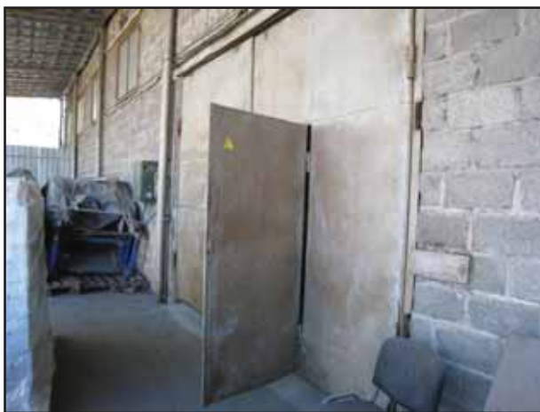
Фото № 21. Внешний вид здания склада
