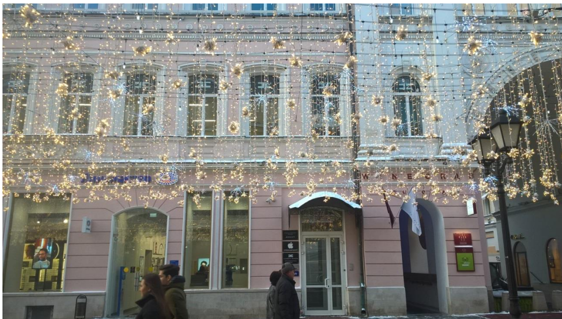
Фото 1. Внешний вид здания
