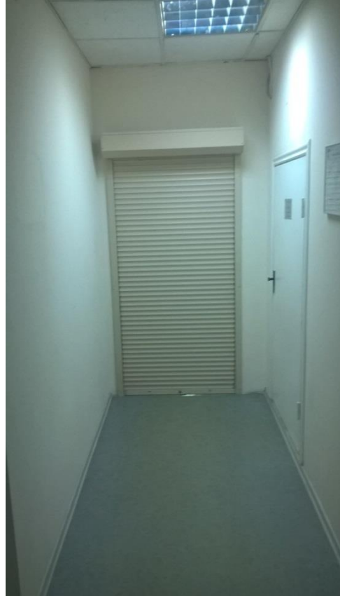
Фото 5. Состояние мест общего пользования в здании
