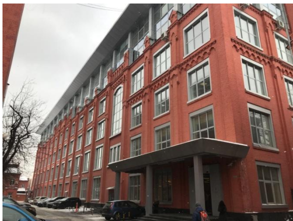
Фото 1. Общий вид здания
