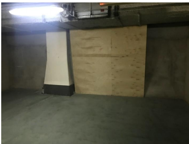
Фото 4. Состояние внутренних помещений
