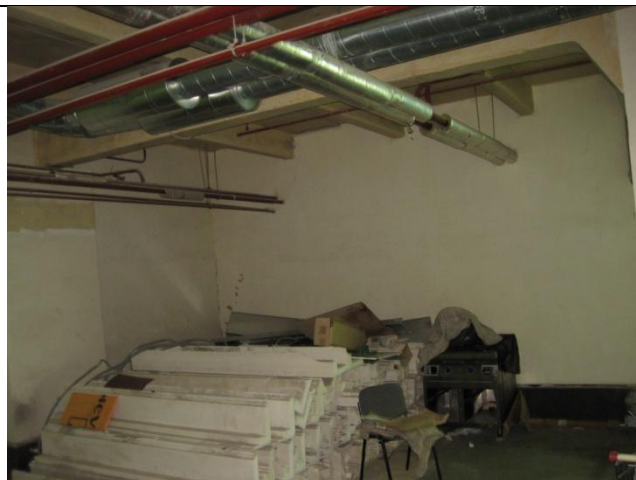
Фото 6. Состояние внутренних помещений
