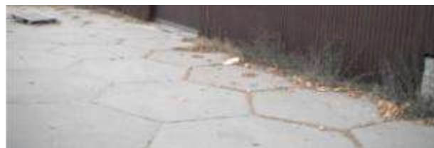
Инв.№70000126, Дорога из ж/бетонных плит на территории
