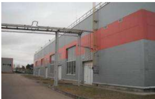
Общий вид здания ТЭБ
