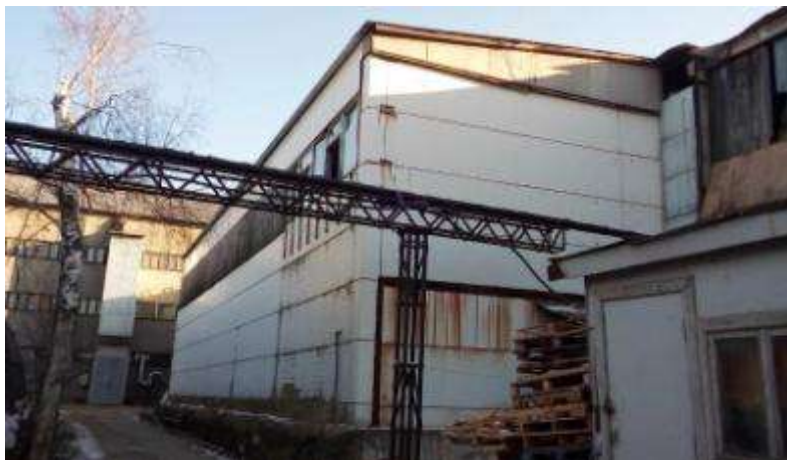
Инв.50000011, Холодильник 600 тонн
