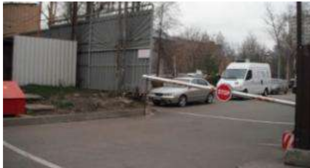
Инв.№70000120, Подъездная дорога к комплексам 980 м2 а/бетонные
