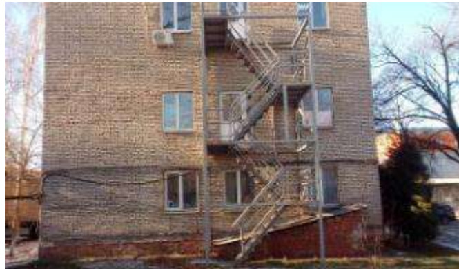
Инв.№70000731, Лестница пожарная эвакуационная, неотделимое улучшение объекта инв.№50000019, Контора зверосовхоза, 3-этажный (рисунок 59,с.112)
