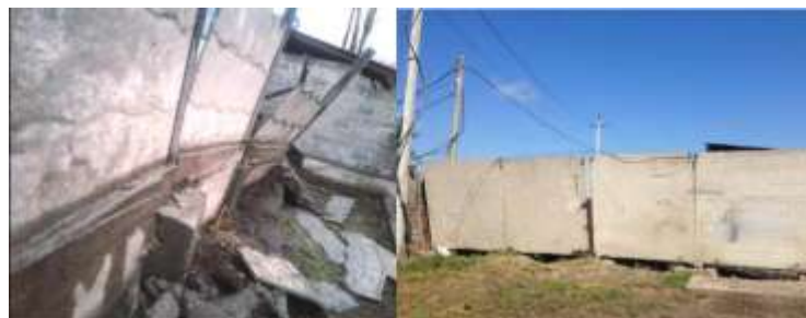
Инв.№70000727, Ограждение протяженностью 322 м и h 2 м
