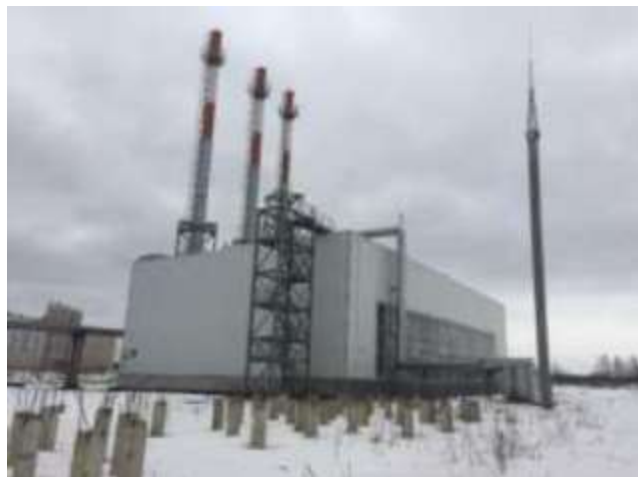
Рисунок 7.6. Здание котельной (I пусковой комплекс ГТЭС «Щербинка»)
