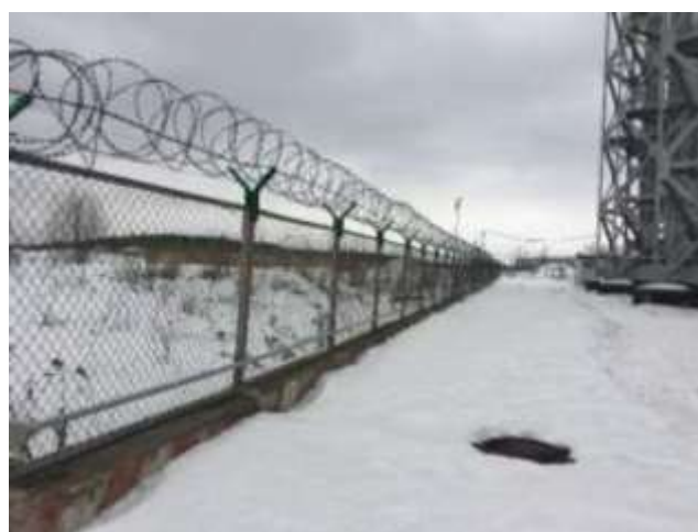
Рисунок 7.10. Ограждение территории (I пусковой комплекс ГТЭС «Щербинка»)
