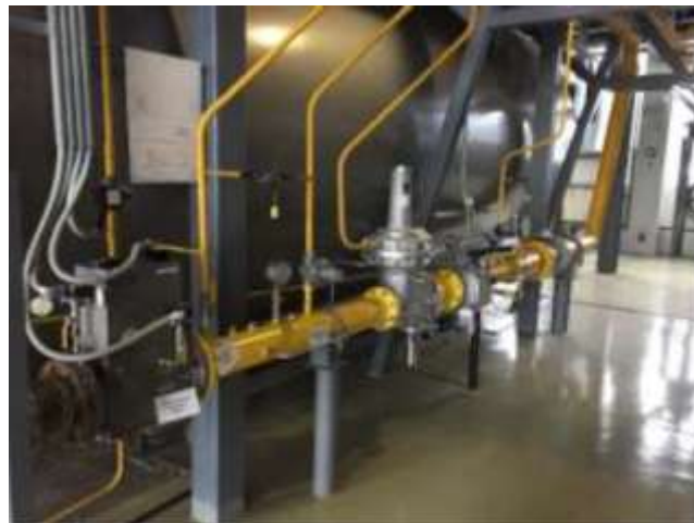
Рисунок 7.14. Газовая рампа DNE125-RS251/DN100-DNA125 (I пусковой комплекс ГТЭС «Щербинка»)
