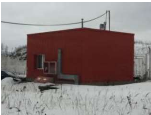
Рисунок 7.9. КПП (I пусковой комплекс ГТЭС «Щербинка»)
