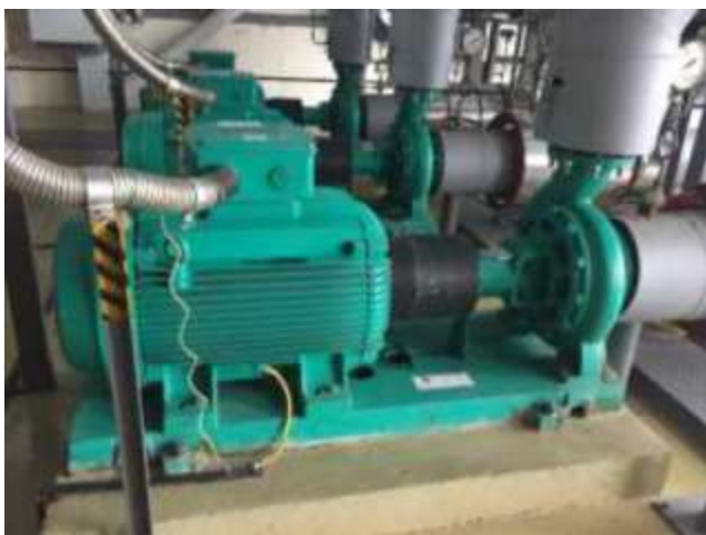
Рисунок 7.15. Группа сетевых насосов Wilo IL100/160-2.2/4 (I пусковой комплекс ГТЭС «Щербинка»)
