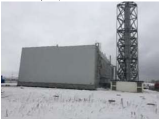
Рисунок 7.5. Здание котельной (I пусковой комплекс ГТЭС «Щербинка»)
