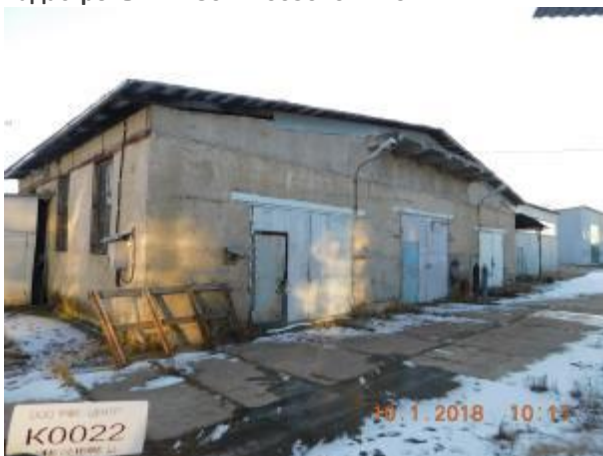
Фото 7.9 Нежилое здание, ремонтный бокс, кадастровый № 50:27:0030704:173
