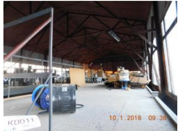
Фото 7.8 Нежилое здание, обойный цех, кадастровый № 50:27:0030704:176
