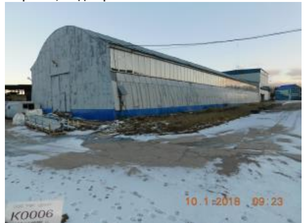
Фото 7.30. Нежилое здание, цех изготовления кирпича, кадастровый № 50:27:000000:45211.
