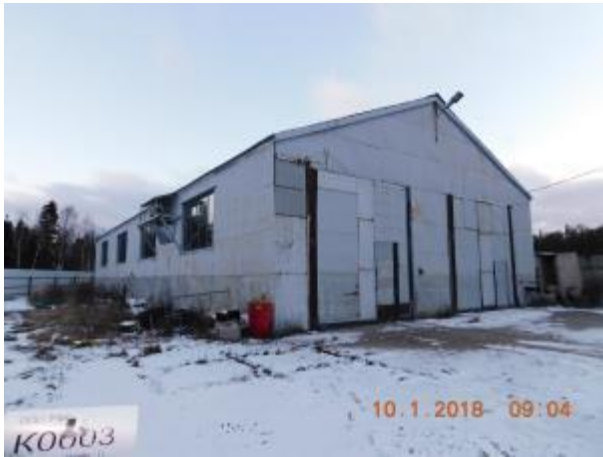
Фото 7.13 Нежилое здание склад, кадастровый № 50:27:0030704:175
