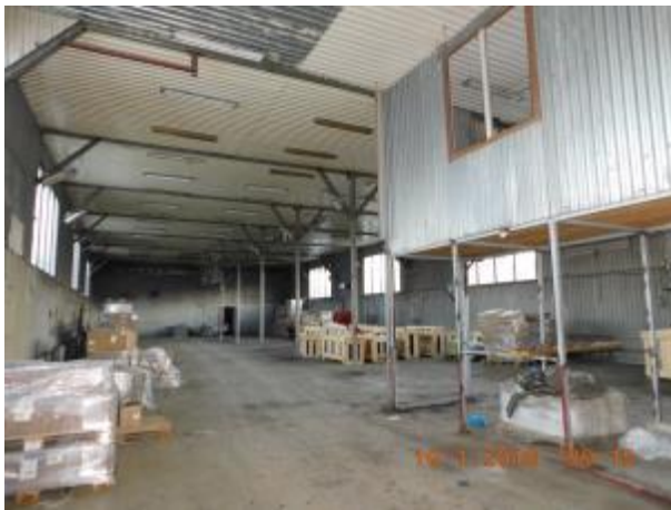
Фото 7.15 Нежилое здание склад, кадастровый № 50:27:0030704:175
