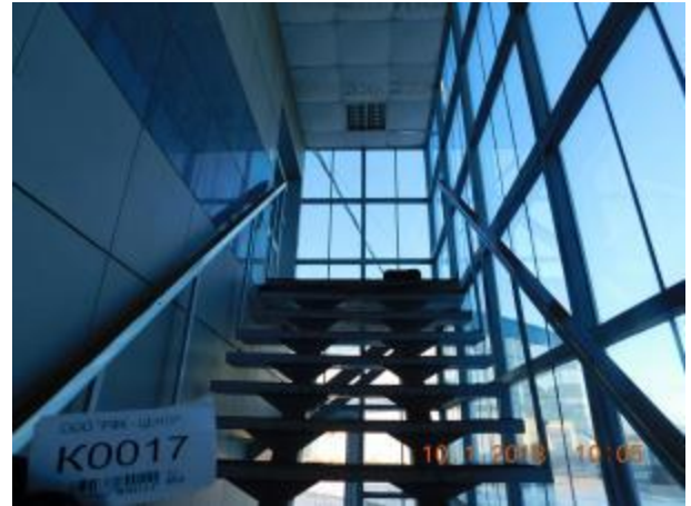
Фото 7.20. Нежилое здание, склад и бытовые помещения, кадастровый № 50:27:0030704:133
