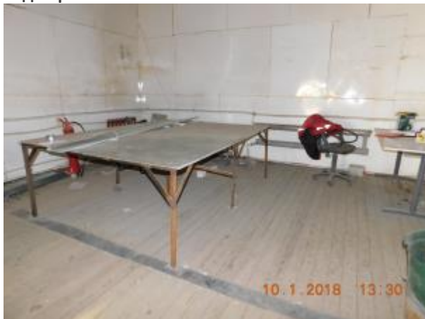
Фото 7.11 Нежилое здание, ремонтный бокс, кадастровый № 50:27:0030704:173
