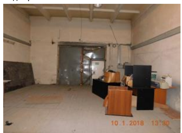
Фото 7.12. Нежилое здание, ремонтный бокс, кадастровый № 50:27:0030704:173
