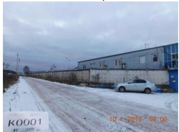
Фото 7.86. Ограждение территории с воротами раздвижными и калиткой.
