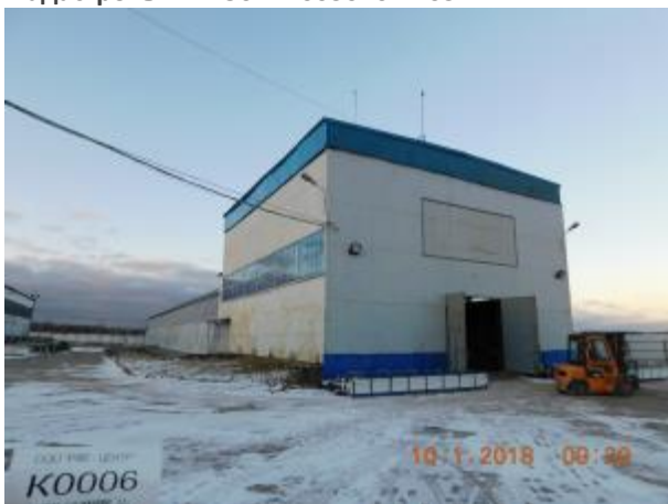
Фото 7.27 Нежилое здание, цех изготовления кирпича, кадастровый № 50:27:000000:45211.
