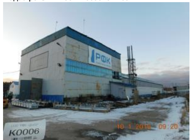
Фото 7.28. Нежилое здание, цех изготовления кирпича, кадастровый № 50:27:000000:45211.
