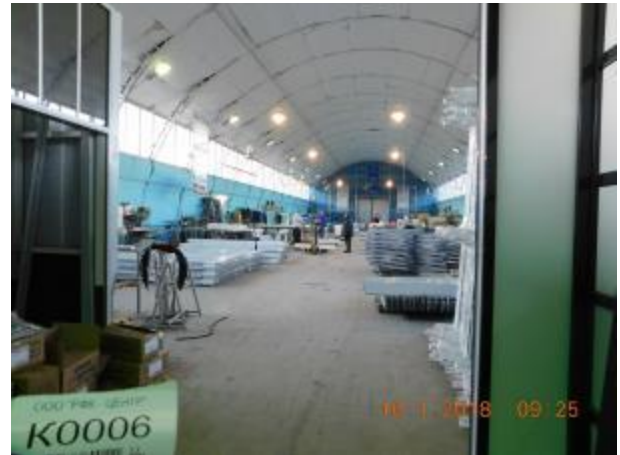
Фото 7.32. Нежилое здание, цех изготовления кирпича, кадастровый № 50:27:000000:45211.
