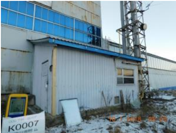
Фото 7.87 Пристройка к зданию.
