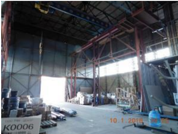
Фото 7.31 Нежилое здание, цех изготовления кирпича, кадастровый № 50:27:000000:45211.
