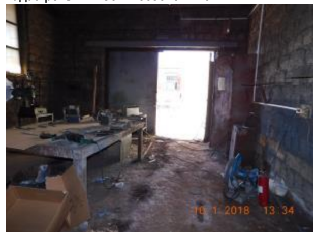
Фото 7.10. Нежилое здание, ремонтный бокс, кадастровый № 50:27:0030704:173
