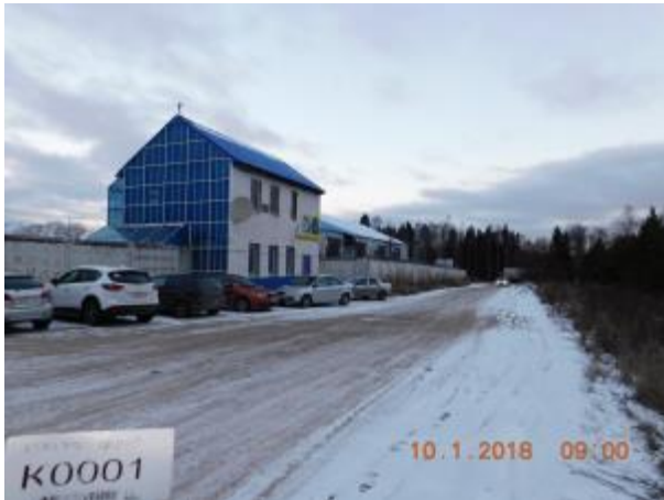
Фото 7.1 Нежилое здание, административно-хозяйственный корпус, кадастровый № 50:27:0030704:162
