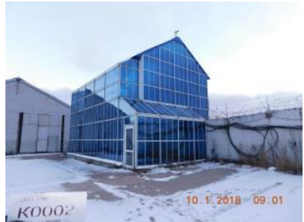
Фото 7.2. Нежилое здание, административно-хозяйственный корпус, кадастровый № 50:27:0030704:162
