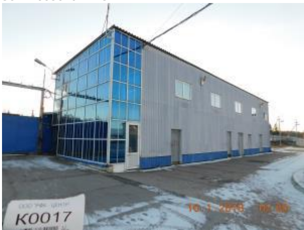
Фото 7.17 Нежилое здание, склад и бытовые помещения, кадастровый № 50:27:0030704:133
