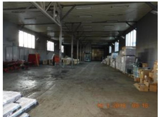
Фото 7.16. Нежилое здание склад, кадастровый № 50:27:0030704:175
