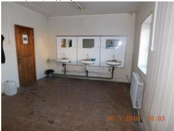
Фото 7.21 Нежилое здание, склад и бытовые помещения, кадастровый № 50:27:0030704:133
