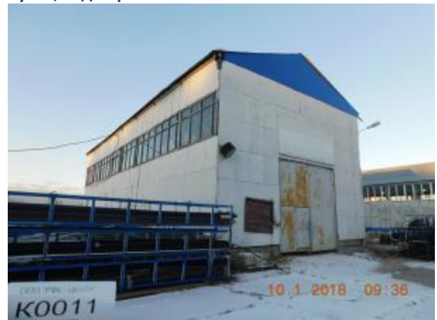
Фото 7.6. Нежилое здание, обойный цех, кадастровый № 50:27:0030704:176
