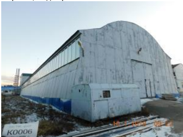
Фото 7.29 Нежилое здание, цех изготовления кирпича, кадастровый № 50:27:000000:45211.
