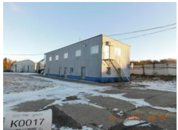
Фото 7.18. Нежилое здание, склад и бытовые помещения, кадастровый № 50:27:0030704:133
