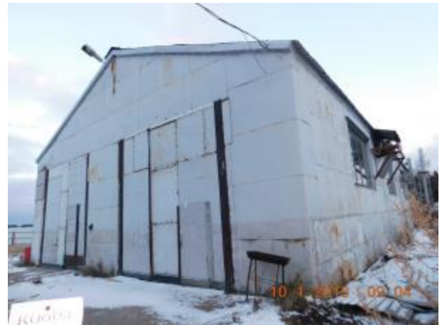
Фото 7.14. Нежилое здание склад, кадастровый № 50:27:0030704:175
