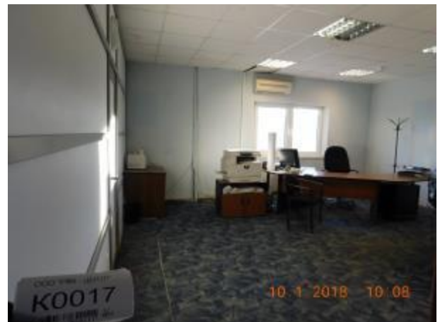
Фото 7.22. Нежилое здание, склад и бытовые помещения, кадастровый № 50:27:0030704:133
