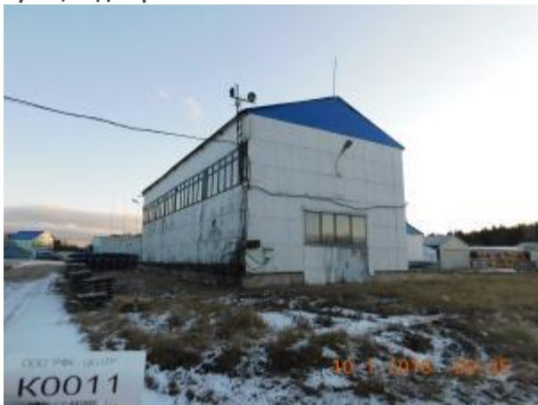
Фото 7.5 Нежилое здание, обойный цех, кадастровый № 50:27:0030704:176
