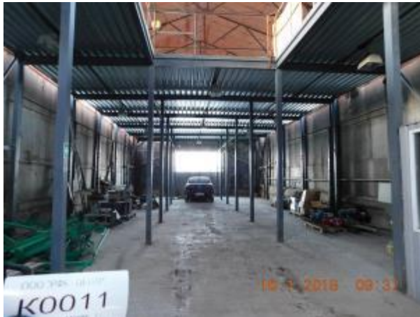
Фото 7.7. Нежилое здание, обойный цех, кадастровый № 50:27:0030704:176
