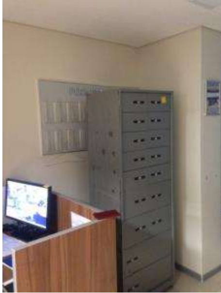
Фото 6.97 Техническое состояние внутренней отделки помещения
