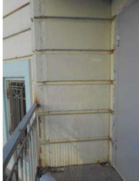
Фото 6.48 Техническое состояние внутренней отделки помещения
