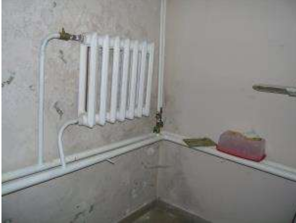
Фото 6.89 Техническое состояние внутренней отделки помещения
