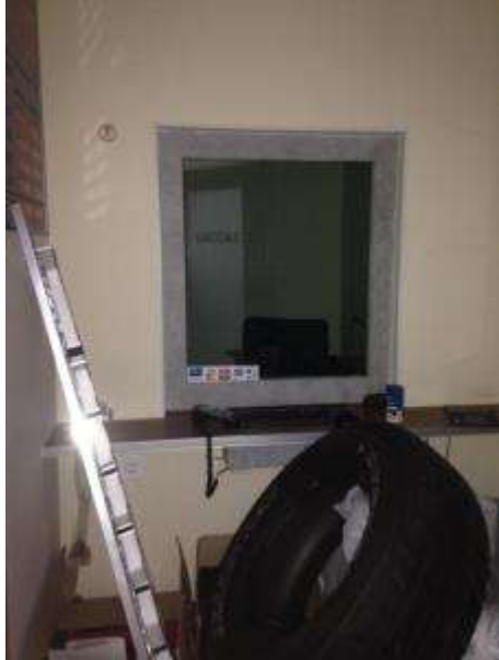
Фото 6.60 Техническое состояние внутренней отделки помещения
