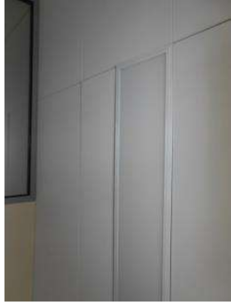
Фото 6.22 Техническое состояние внутренней отделки помещения
