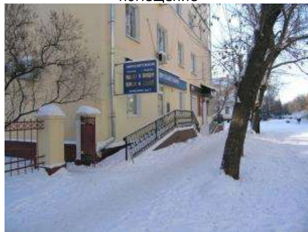
Фото 6.71 Фасад здания; вход в помещение
