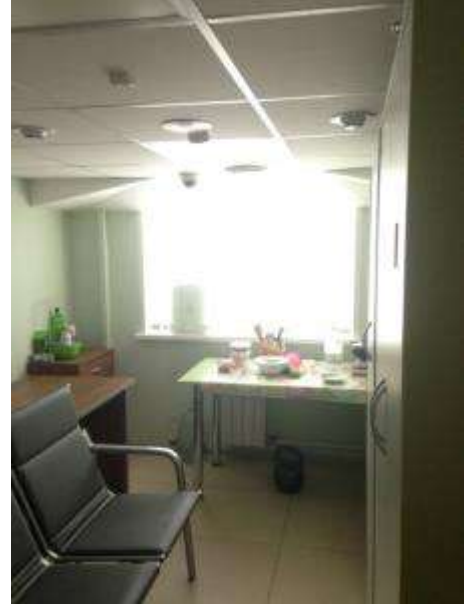
Фото 6.98 Техническое состояние внутренней отделки помещения
