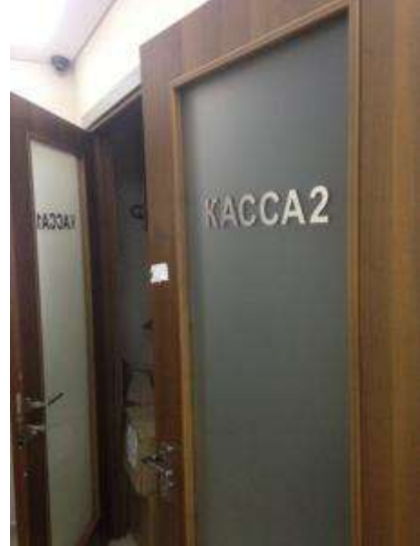
Фото 6.61 Техническое состояние внутренней отделки помещения
