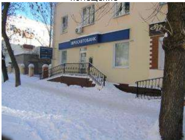
Фото 6.70 Фасад здания; вход в помещение
