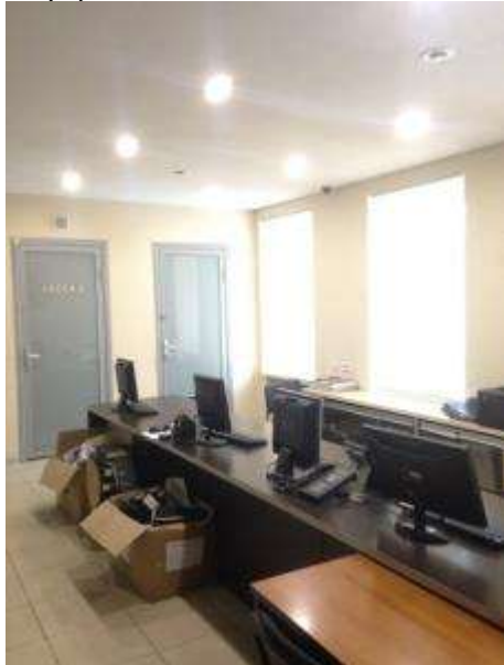
Фото 6.68 Техническое состояние внутренней отделки помещения
