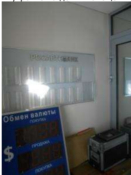
Фото 6.17 Техническое состояние внутренней отделки помещения
