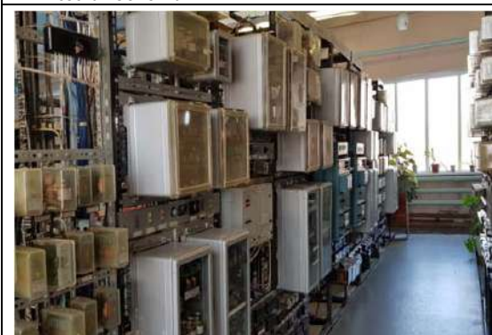
ФОТО № 17. Внутренний вид здания РП-220, входящего в состав Объекта №1
