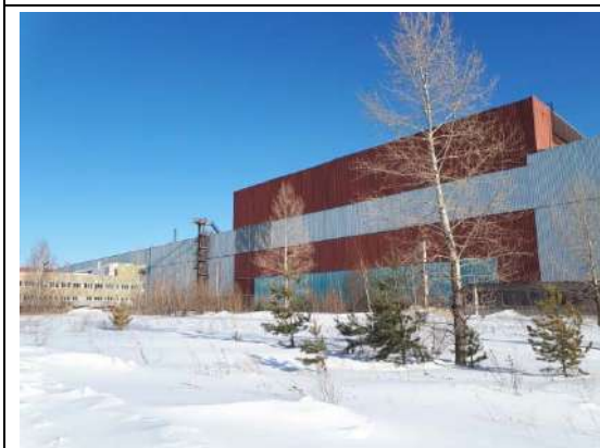
ФОТО № 11. Внешний вид сооружения, производственного корпуса стального литья, входящего в состав Объекта №1
