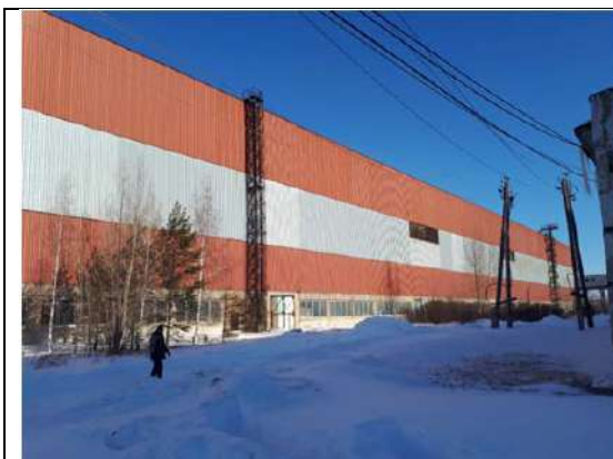
ФОТО № 5. Внешний вид сооружения, нежилого здания, входящего в состав Объекта № 1
