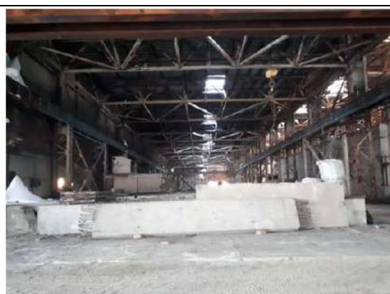
ФОТО № 6. Внутренний вид сооружения, нежилого здания, входящего в состав Объекта № 1
