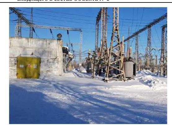
ФОТО № 16. Внешний вид здания РП-220, входящего в состав Объекта №1
