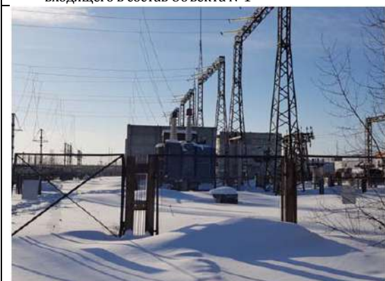
ФОТО № 15. Внешний вид здания ГПП-2, входящего в состав Объекта №1
