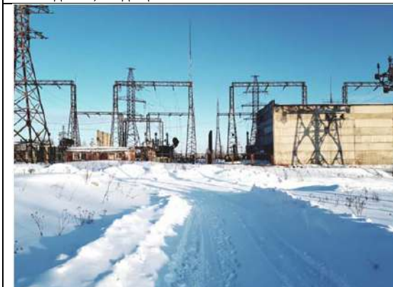
ФОТО № 7. Внешний вид здания, входящего в состав Объекта №1
