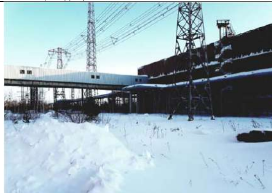
ФОТО № 10. Внешний вид сооружения, производственного корпуса стального литья, входящего в состав Объекта №1
