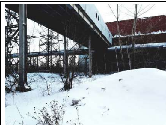
ФОТО № 13. Внешний вид сооружения, производственного корпуса стального литья, входящего в состав Объекта №1
