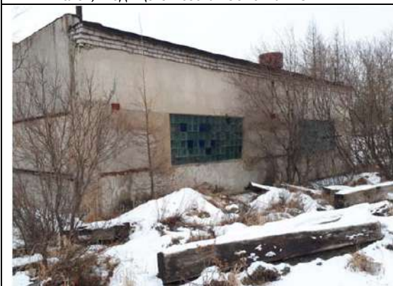
ФОТО № 25. Внешний вид здания трансформаторной, входящего в состав Объекта №3
