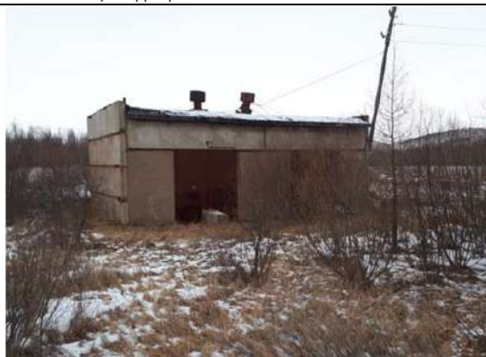
ФОТО № 24. Внешний вид здания трансформаторной, входящего в состав Объекта №3
