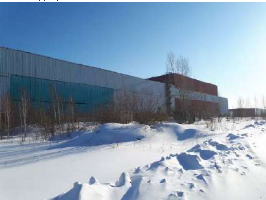
ФОТО № 12. Внешний вид сооружения, производственного корпуса стального литья, входящего в состав Объекта №1
