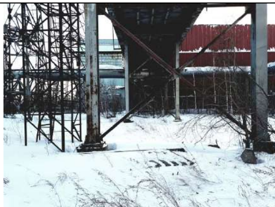
ФОТО № 14. Внешний вид сооружения, производственного корпуса стального литья, входящего в состав Объекта №1
