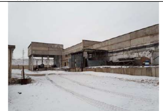
ФОТО № 18. Внутренний вид здания, склада ОМТС, входящего в состав Объекта №2
