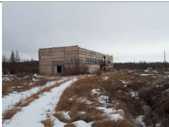
ФОТО № 22. Внешний вид здания, склада масел и кислот, входящего в состав Объекта №3
