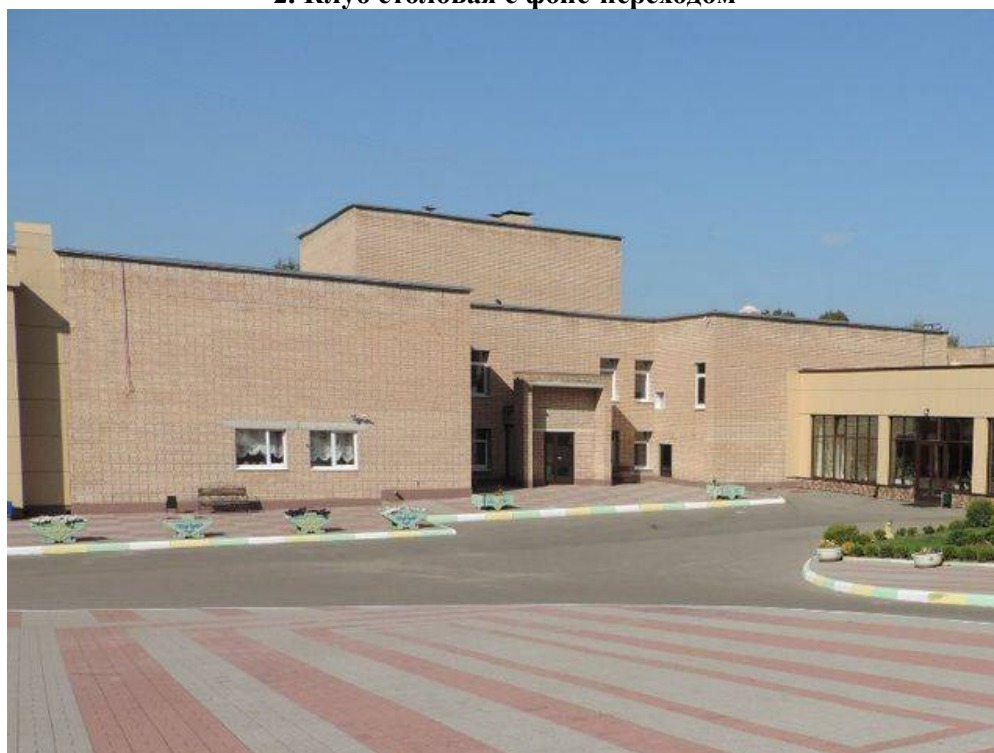
Фото №6. Внешний вид здания
