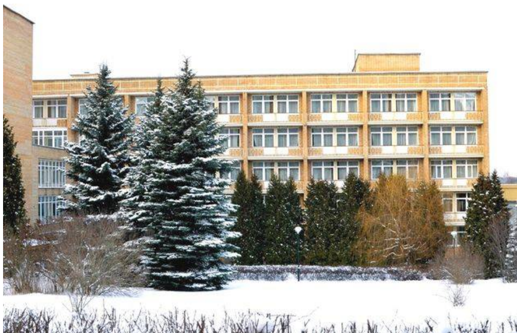
Фото №2. Внешний вид здания
