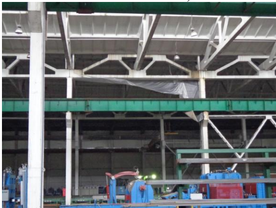
Здание производственного корпуса (степень готовности 85%)
