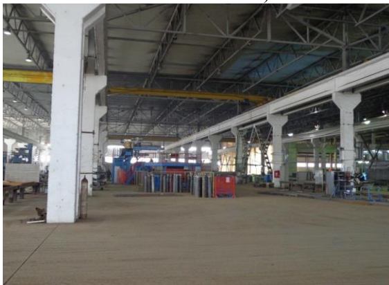
Здание производственного корпуса (степень готовности 85%)
