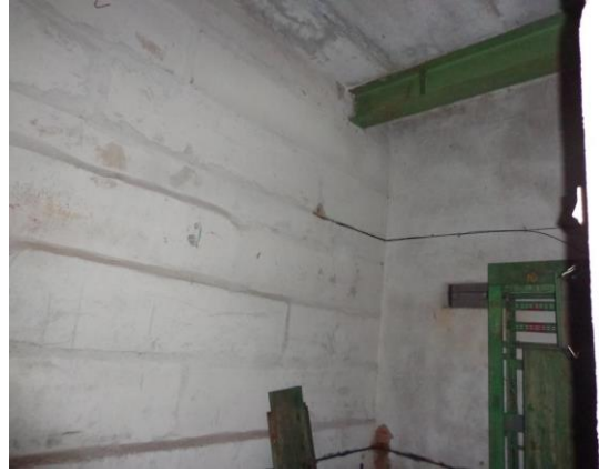
Здание ТП-1808 (степень готовности 85%)
