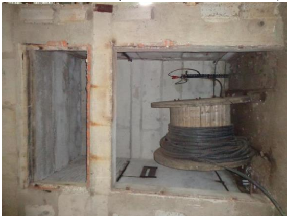
Здание ТП-1808 (степень готовности 85%)
