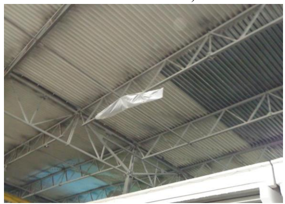
Здание производственного корпуса (степень готовности 85%)
