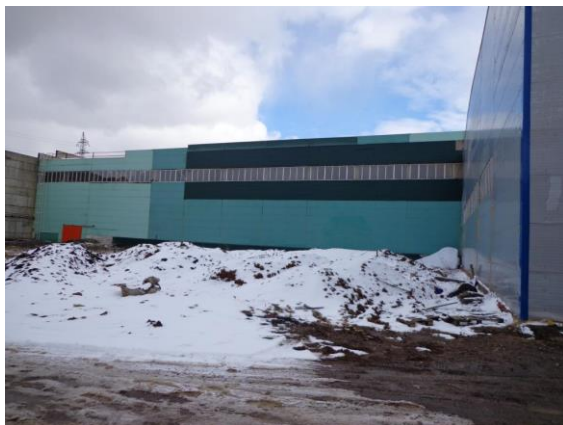
Здание производственного корпуса (степень готовности 85%)
