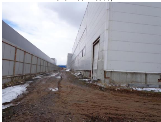
Здание производственного корпуса (степень готовности 85%)
