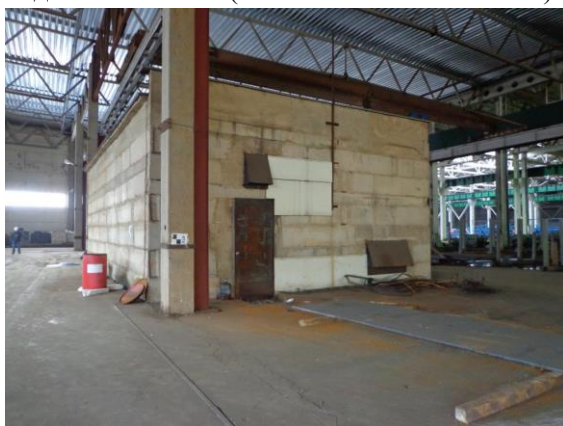
Здание ТП-1808 (степень готовности 85%)
