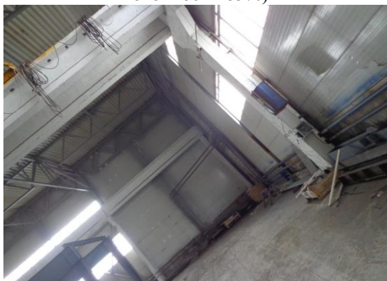
Здание производственного корпуса (степень готовности 85%)
