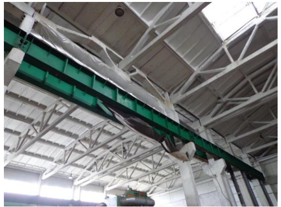
Здание производственного корпуса (степень готовности 85%)
