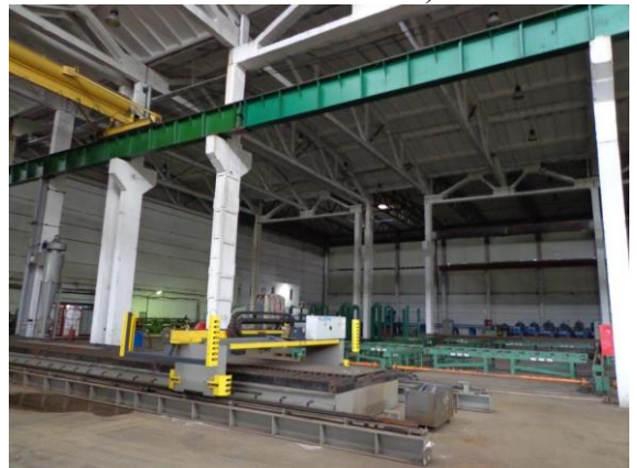
Здание производственного корпуса (степень готовности 85%)
