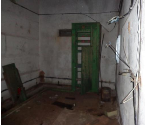
Здание ТП-1808 (степень готовности 85%)
