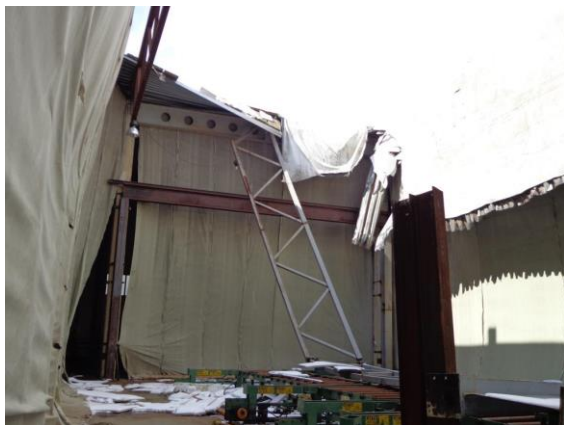
Здание производственного корпуса (степень готовности 85%)
