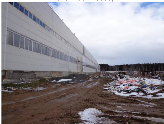
Здание производственного корпуса (степень готовности 85%)
