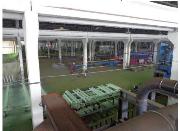
Здание производственного корпуса (степень
