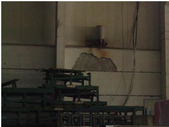
Здание производственного корпуса (степень готовности 85%)
