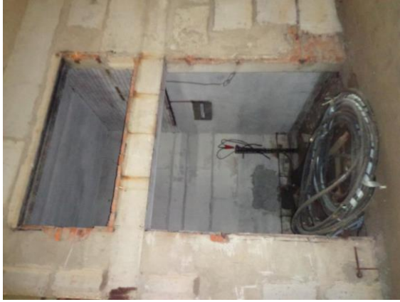
Здание ТП-1808 (степень готовности 85%)
