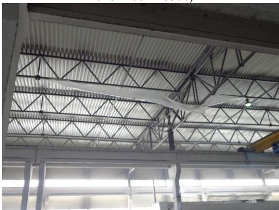
Здание производственного корпуса (степень
