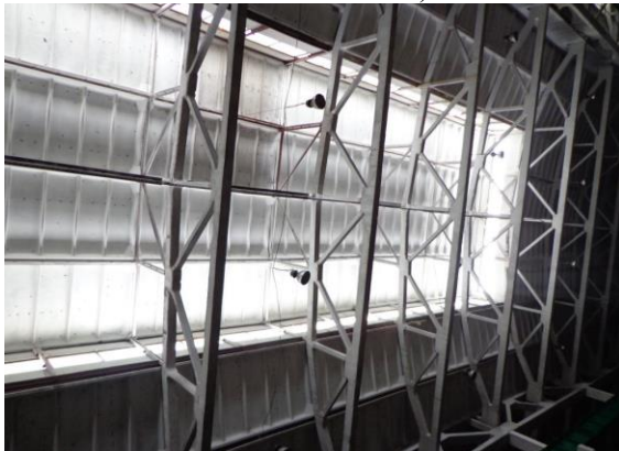
Здание производственного корпуса (степень готовности 85%)
