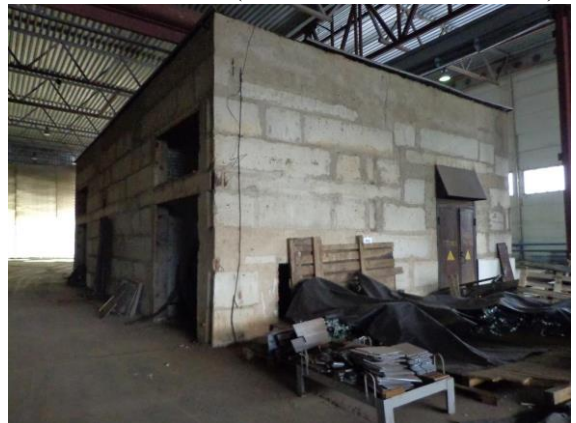
Здание ТП-1808 (степень готовности 85%)
