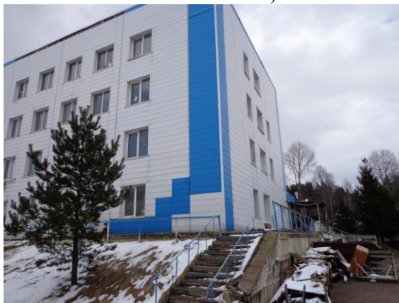
Здание административного корпуса (степень готовности 85%)
