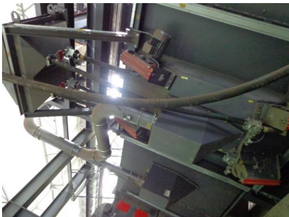
Линия дробемет очистки, покраски и сушки RHBD17/22 ROSLER
