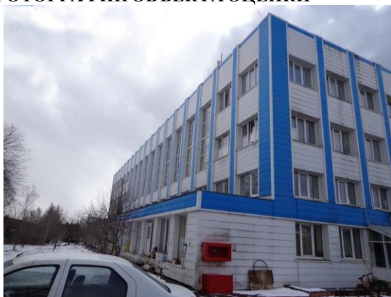
Здание административного корпуса (степень готовности 85%)
