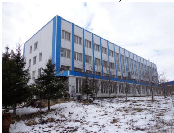
Здание административного корпуса (степень готовности 85%)
