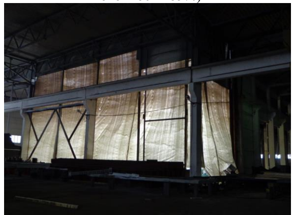
Здание производственного корпуса (степень
