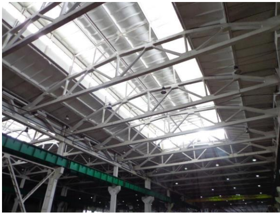
Здание производственного корпуса (степень готовности 85%)
