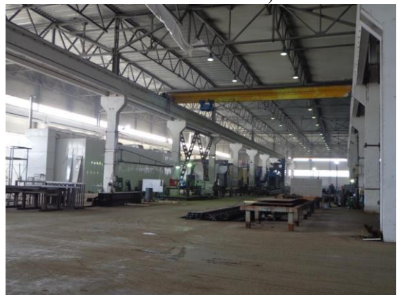
Здание производственного корпуса (степень готовности 85%)
