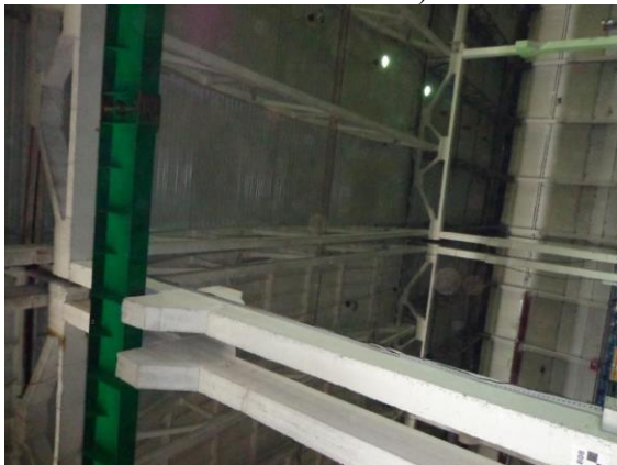
Здание производственного корпуса (степень
