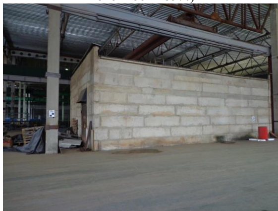
Здание ТП-1808 (степень готовности 85%)
