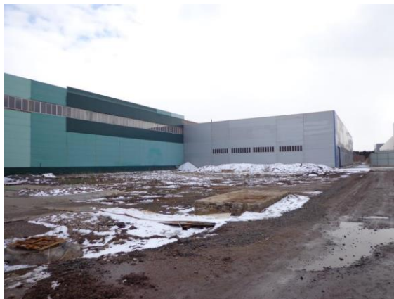
Здание производственного корпуса (степень готовности 85%)
