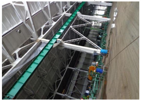
Здание производственного корпуса (степень готовности 85%)
