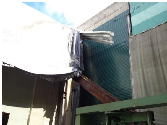
Здание производственного корпуса (степень готовности 85%)
