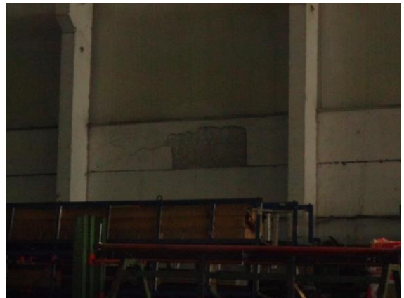
Здание производственного корпуса (степень готовности 85%)
