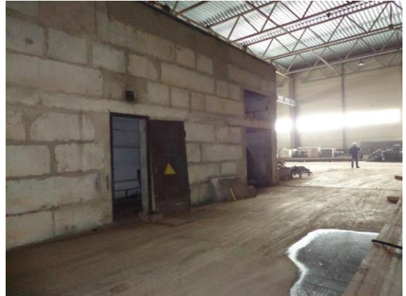
Здание ТП-1808 (степень готовности 85%)
