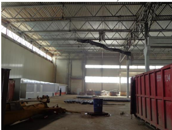
Здание производственного корпуса (степень готовности 85%)
