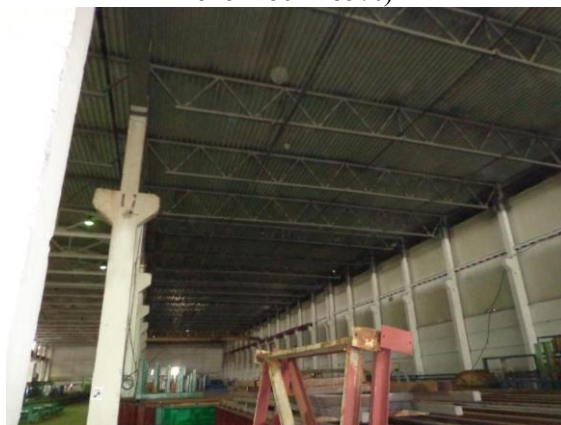
Здание производственного корпуса (степень
