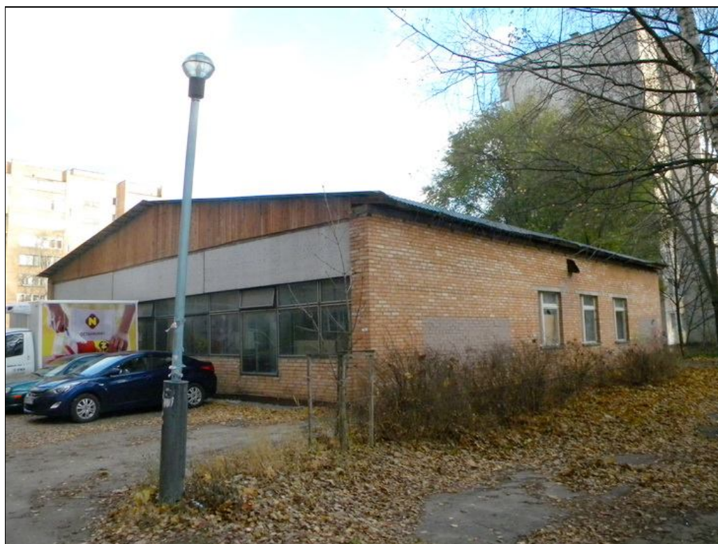
Фото 1. Общий вид здания
