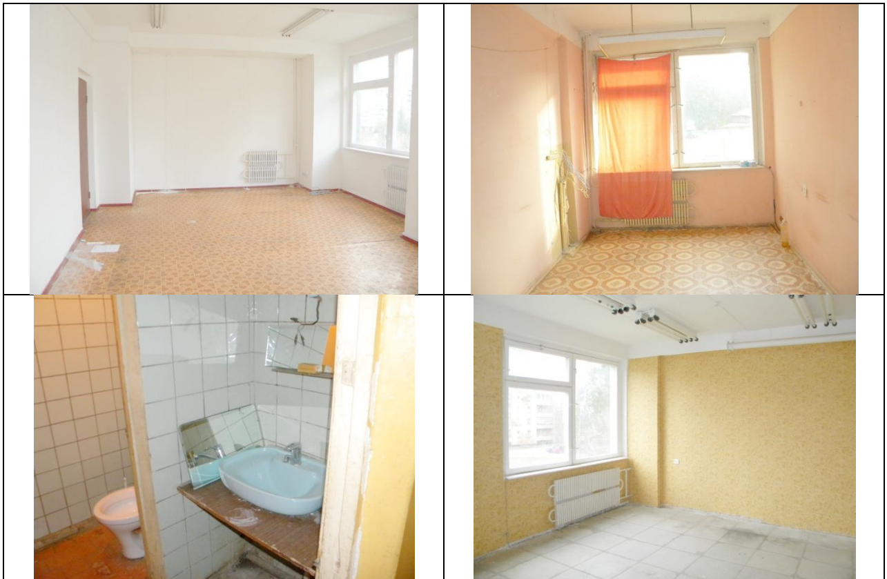
Фото 6. Общий вид помещений внутри здания
