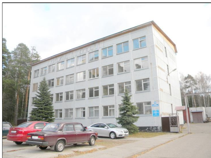
Фото 4. Общий вид здания
