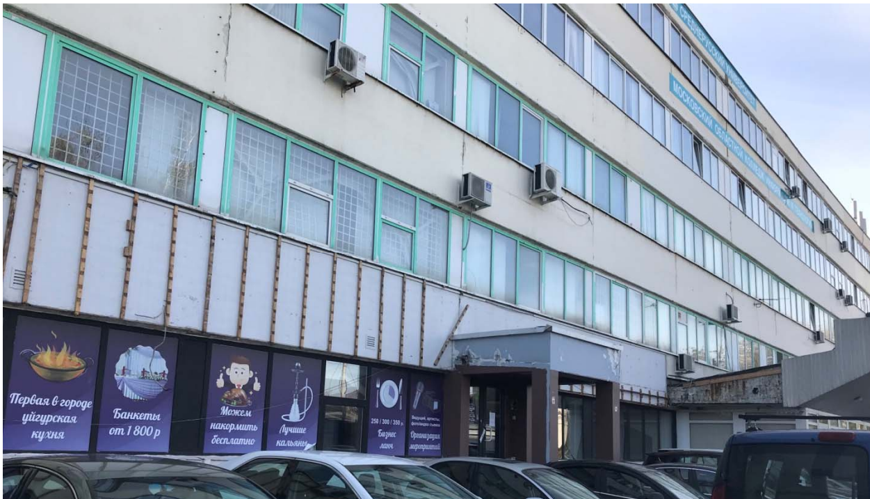
Фото 1. Вход в помещение
