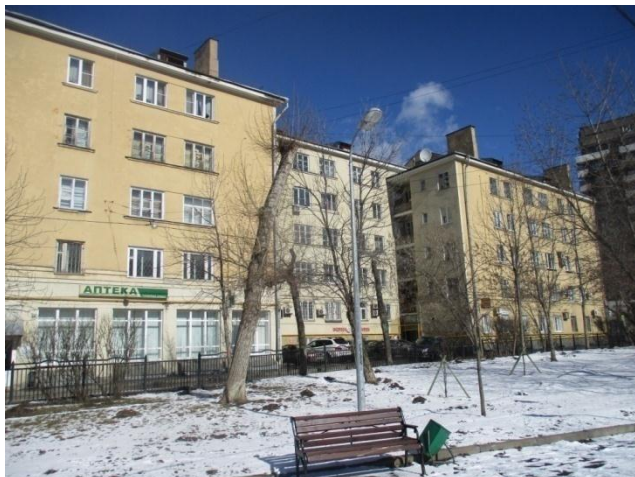
Источник информации: визуальный осмотр Фасад здания с ул. 10-летия Октября Фото 6.5
