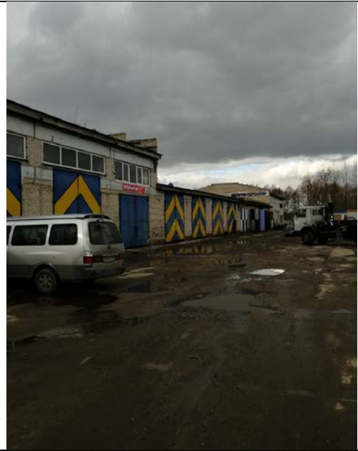
ФОТО № 4. Помещение - гараж, инв. №29
