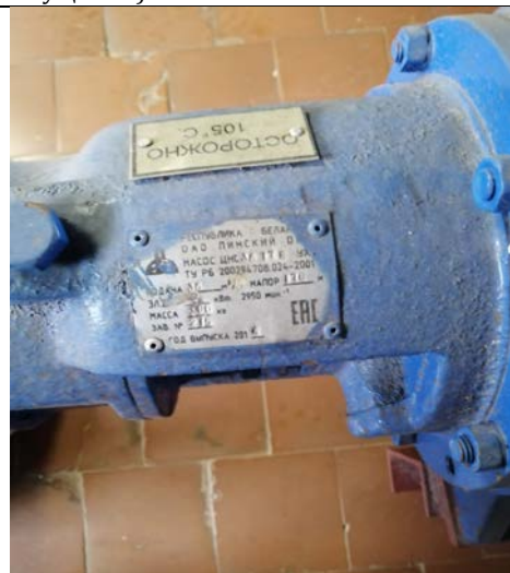
ФОТО № 8. Насос ЦНС(Г) 38-176 с/дв 30/3000/лапы/ИР54/Д48 (ПНСК), инв. 000000149
