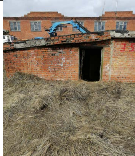
ФОТО № 6. Здание: склад для хранения соли, инв. №35
