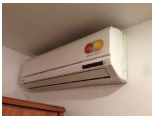
Фото 6.22 Кондиционер Toshiba RAS - 10NK4CX
