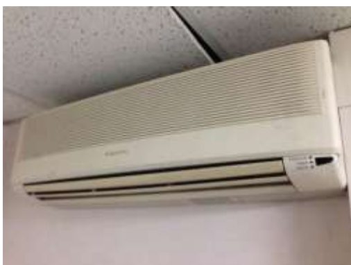
Фото 6.29 Кондиционер HITACHI RAS-07CH1/RAC-07CHV1
