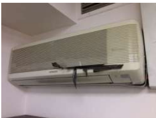
Фото 6.31 Кондиционер HITACHI RAS-09CH1/RAC-09CHV1
