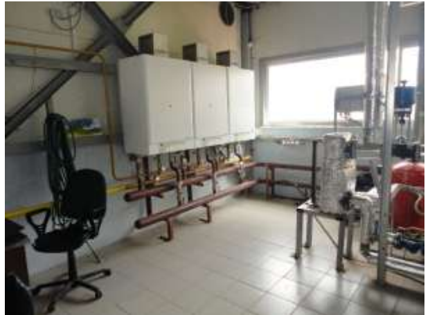
87. Газовая котельная (расширительные баки).
