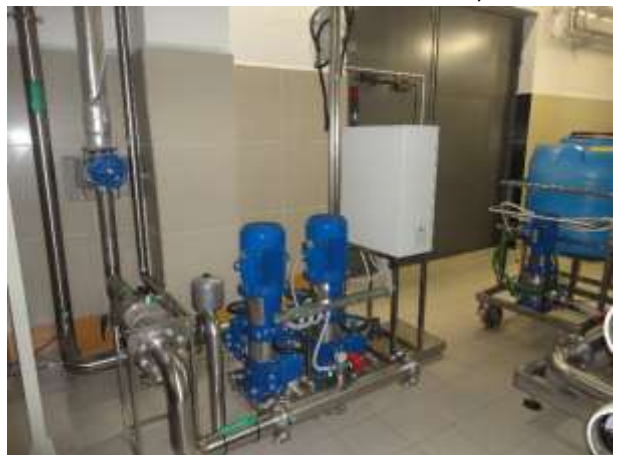
105. Система водоподготовки 40 куб.м.
