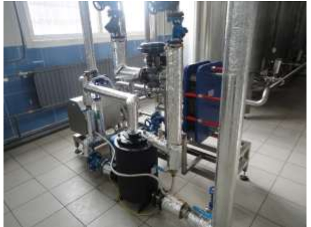
59. Станция СІР (шкаф управления).
