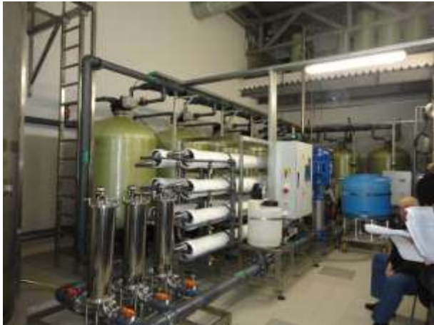
104. Система водоподготовки 40 куб.м.
