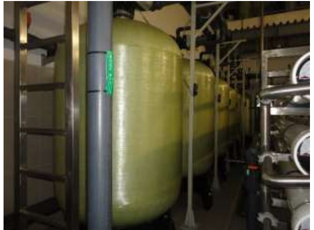
105. Система водоподготовки 40 куб.м.
