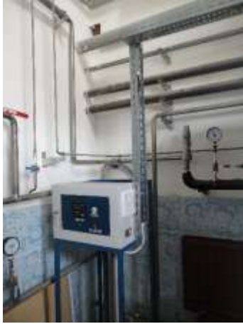
69. Станция углекислого газа.
