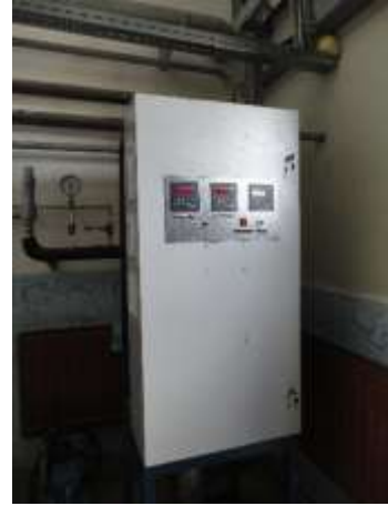
68. Станция углекислого газа.
