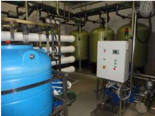
104. Система водоподготовки 40 куб.м.
