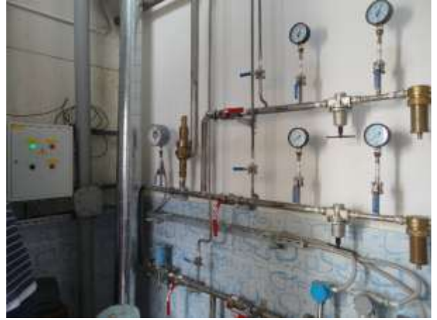
84. Станция углекислого газа (газовые фильтры).
