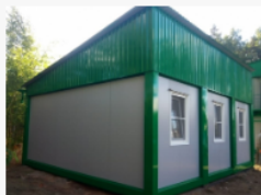
Здание 3 блока июнь 2018
