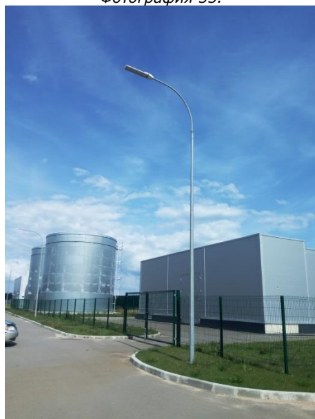
Мачты освещения, высота 20 м
