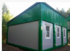
Здание 3 блока июнь 2018
