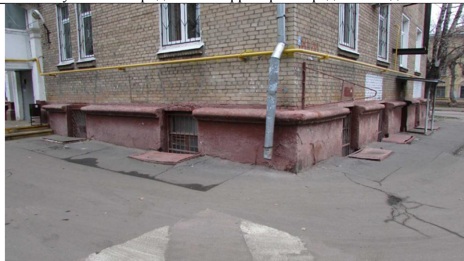
Рисунок 6.21 Придомовая территория перед жилым домом
