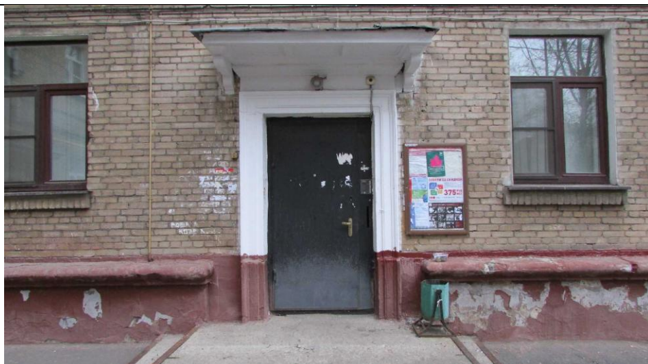
Рисунок 6.18 Вход в помещение (крыльцо, входная группа)
