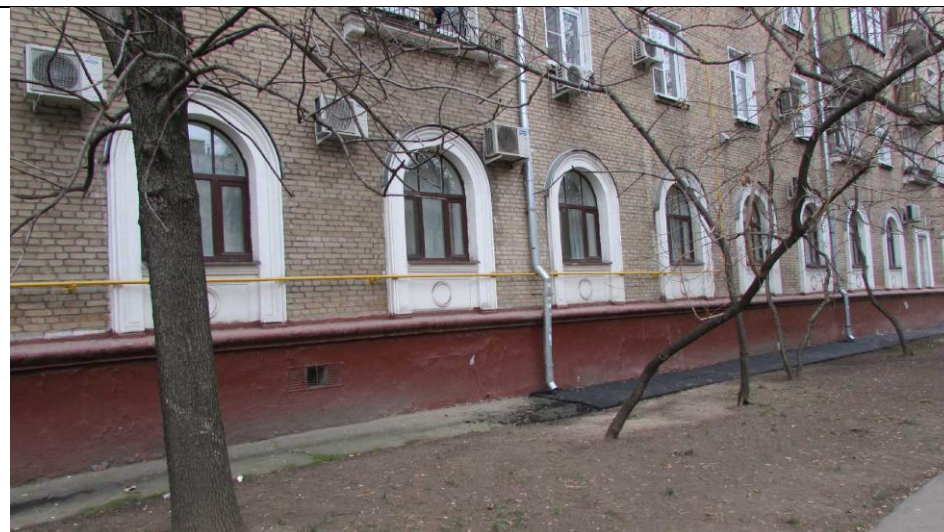
Рисунок 6.19 Придомовая территория перед жилым домом
