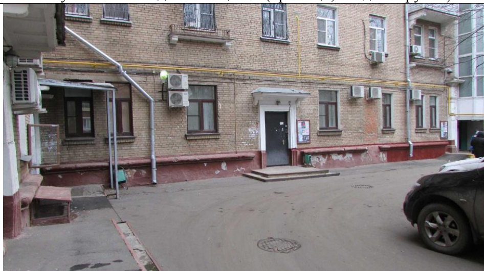
Рисунок 6.20 Вход в помещение (крыльцо, входная группа)
