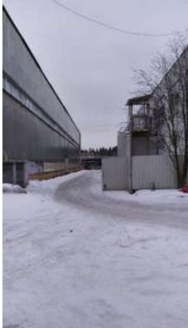
Фото. 6.13 Состояние прилегающей территории
