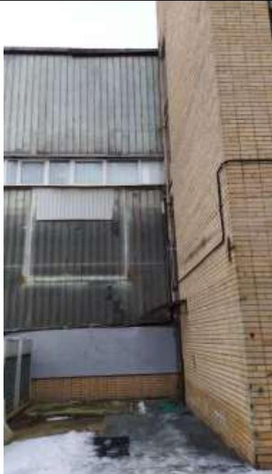
Фото. 6.15 Внешний вид оцениваемого здания
