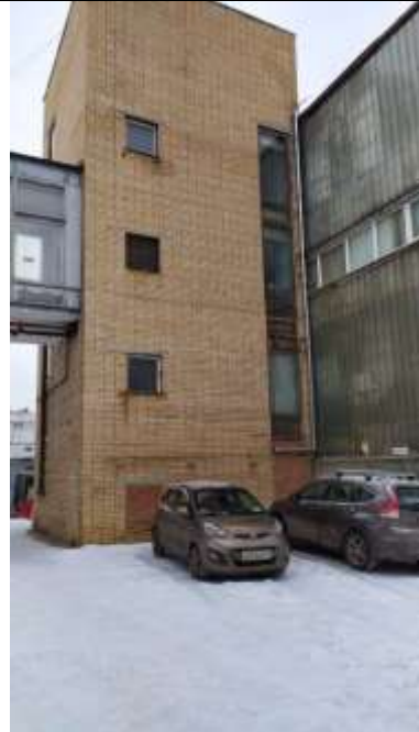
Фото. 6.16 Внешний вид оцениваемого здания
