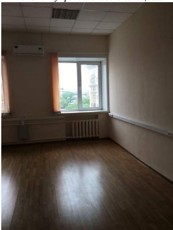
Фото 9. Внутренняя отделка помещений
