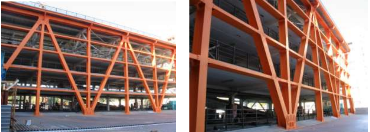
Фото 2. Внешний вид четырехуровневого открытого паркинга, литер А, а, а1, общей площадью 3 466,4 кв.м., расположенный по адресу: Свердловская область, г. Екатеринбург, ул. Уральская, 61 а
