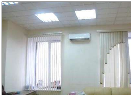
Внутренняя отделка помещений 3 этажа
