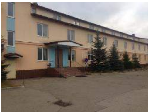
Внешний вид здания
