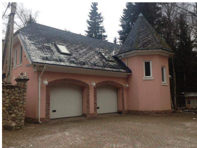
Фасад объекта №6. Земельный участок
