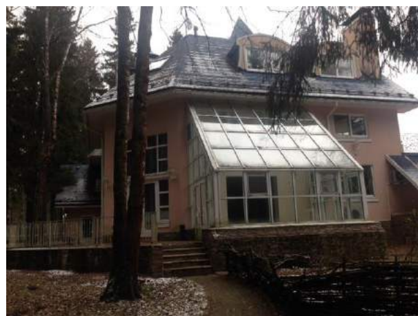
Фасад объекта №7. Земельный участок
